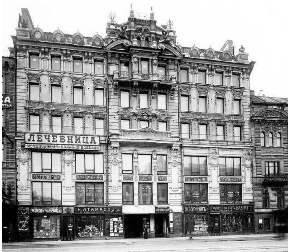
16. Фасад дома № 65 по Невскому проспекту. ЦГАКФФД СПб. Фотодокумент Е 14260. 1903 – 1904 гг.
