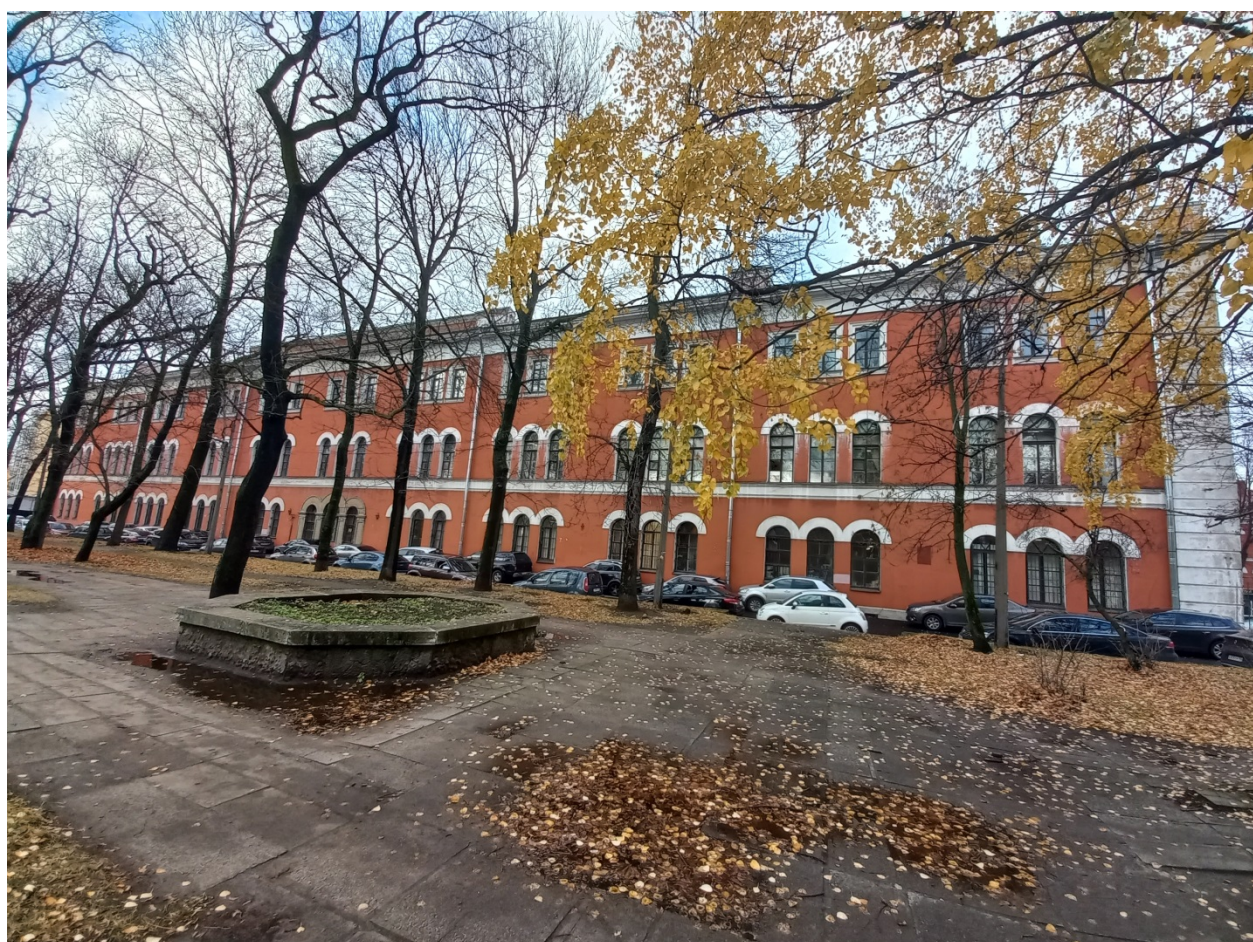
Фото 8. Фасад по ул. Комсомола. Направление съмки – север.
