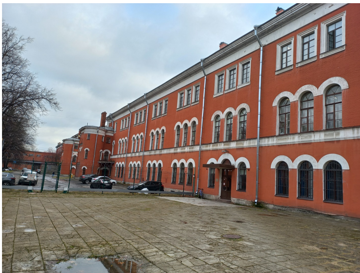
Фото 3. Дворовый фасад. Направление съемки – юго-восток.
