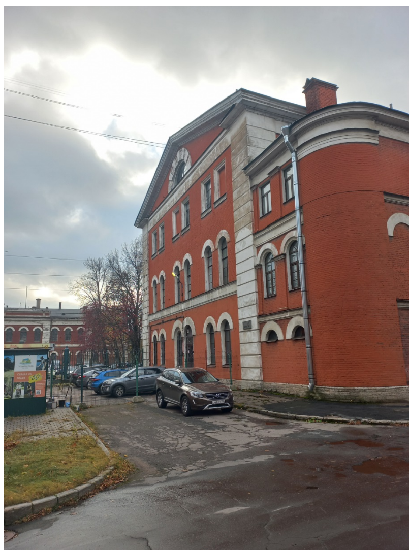
Фото 5. Дворовый и торцевой фасады. Направление съемки – юго-запад.
