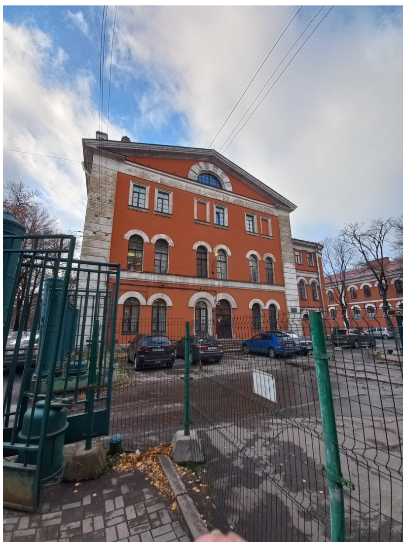
Фото 6. Торцевой фасад. Направление съемки – запад.
