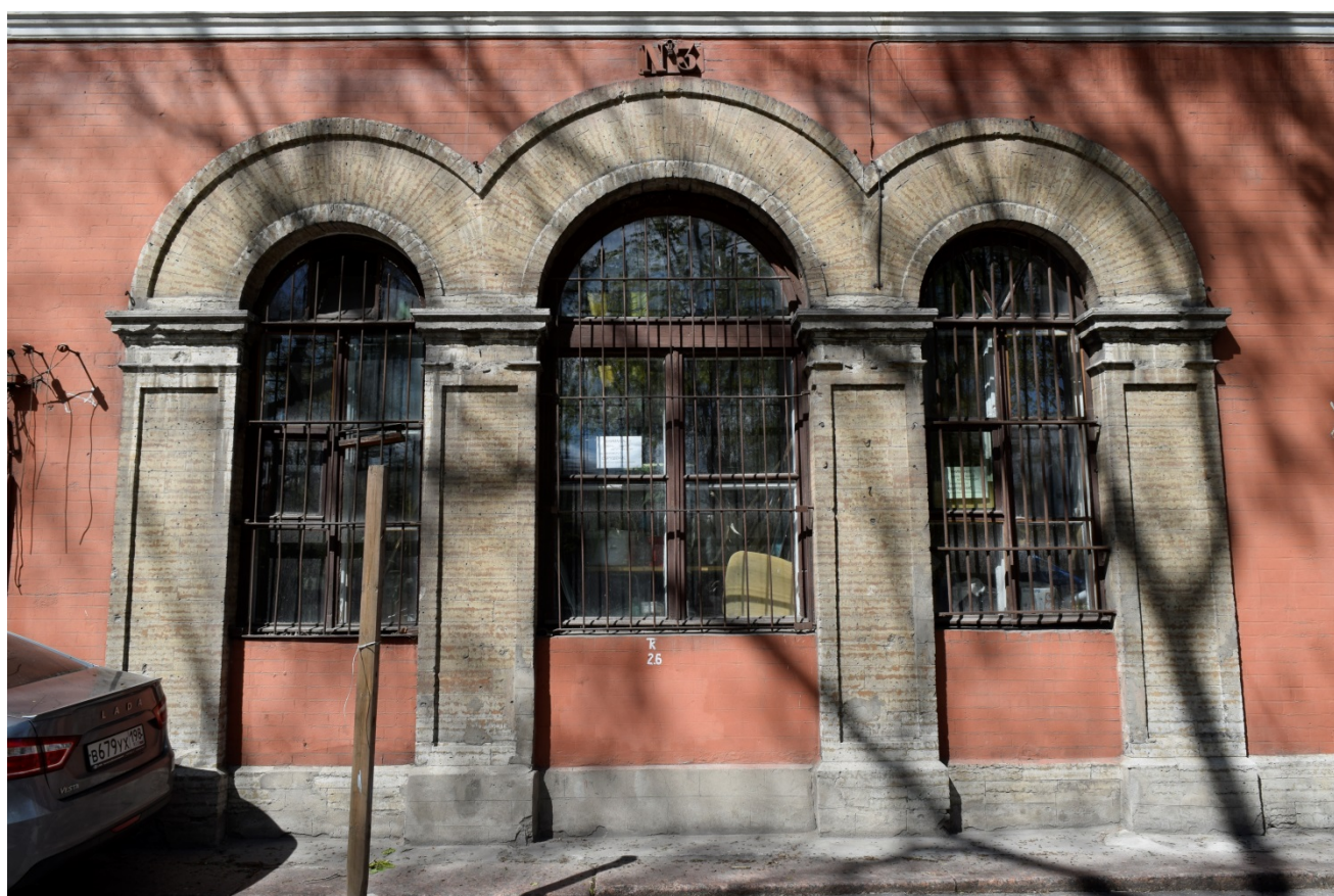
Фото 9. Фасад по ул. Комсомола. Гранитная отмостка. Направление съемки – север.
