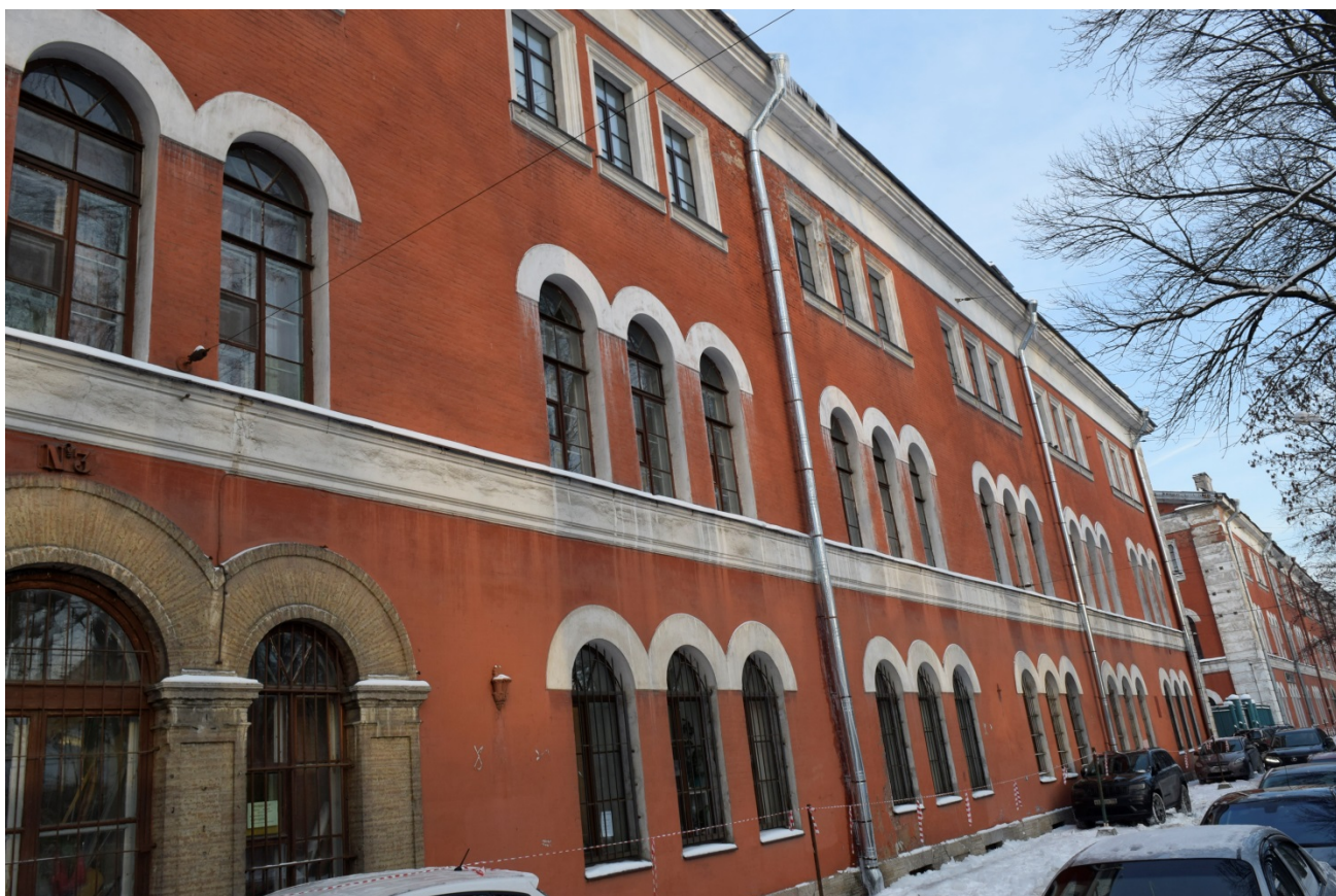
Фото 5*. Южный фасад (фрагмент). Направление съемки – северо-восток.
