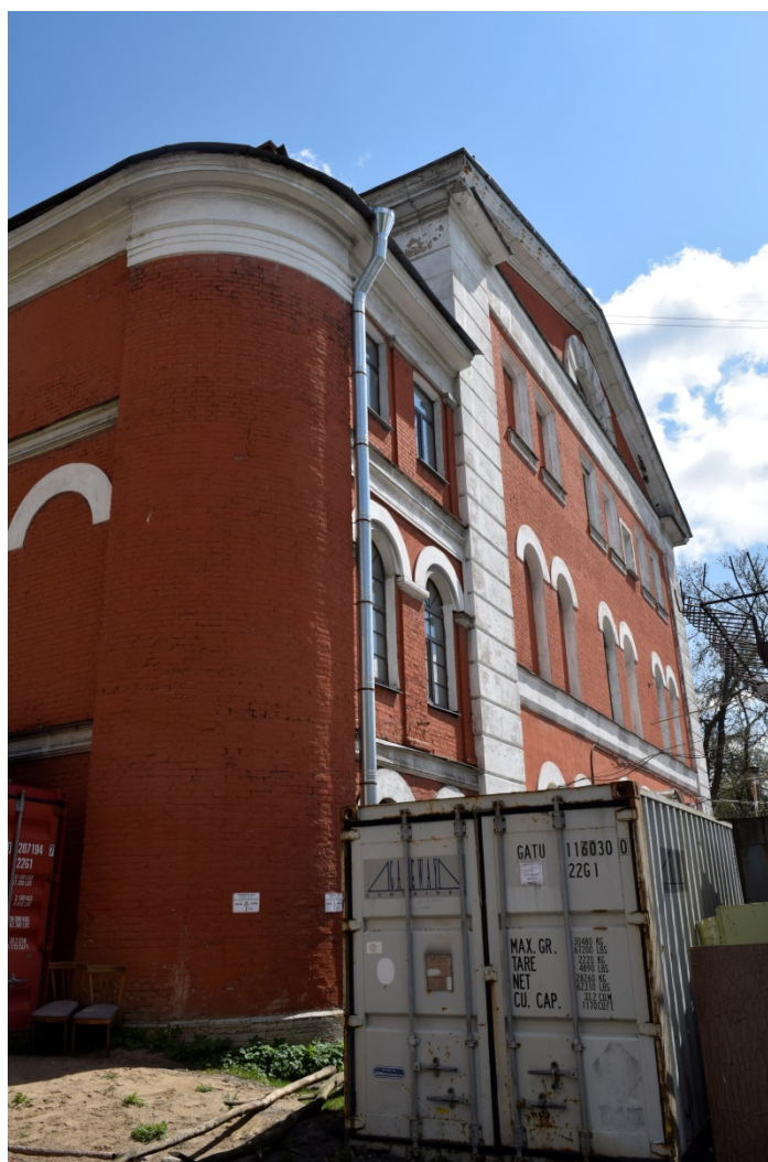
Фото 2*. Западный Фасад. Направление съемки – юго - восток.
