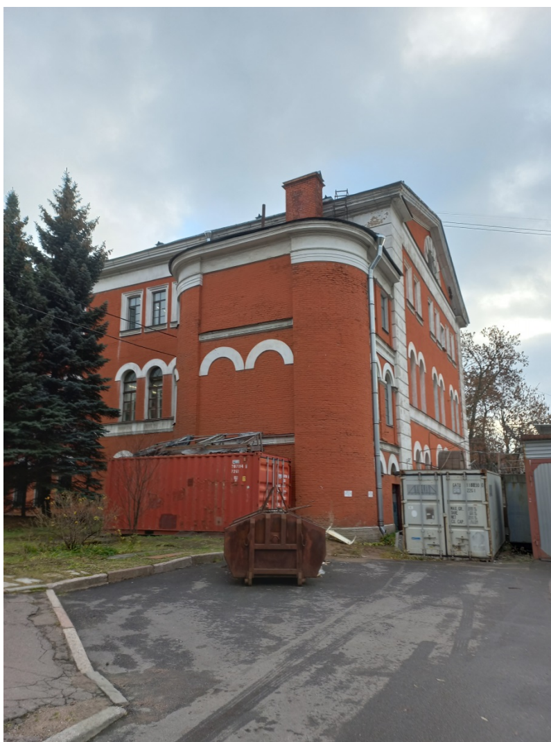
Фото 4. Дворовый и торцевой фасады. Направление съемки – юго-восток.
