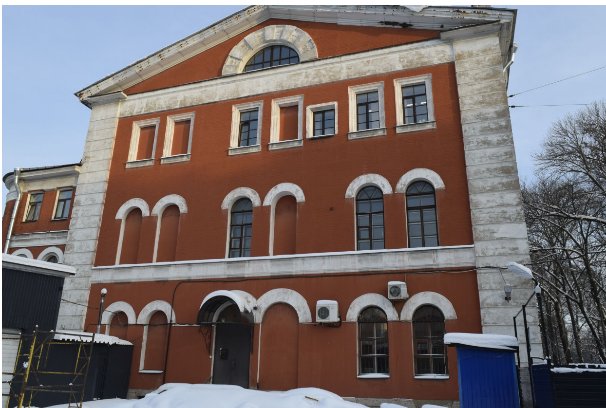
Фото 1*. Западный Фасад. Направление съемки - восток.
