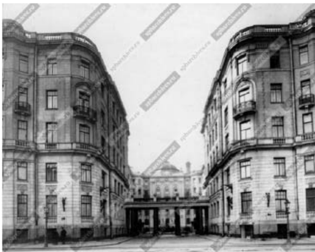
Илл. 73. Центральный фасад дома №26-28 со стороны Каменноостровского проспекта - дом Первого Российского страхового общества (архитекторы Л.Н.Бенуа, Ю.Ю.Бенуа). Дата съемки: [1914-1916 гг.] // Источник: ЦГАКФФД СПб. Архивный шифр: Е 12525.
