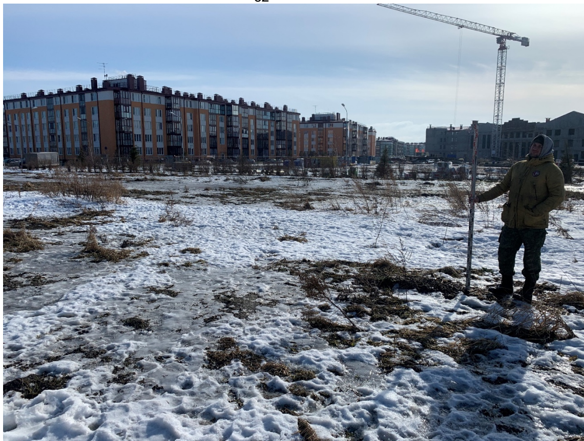
Рис. 16. Шушары, КН:78:42:1850206:6189-2023. Точка фотофиксации 3, вид на юго-восток.
