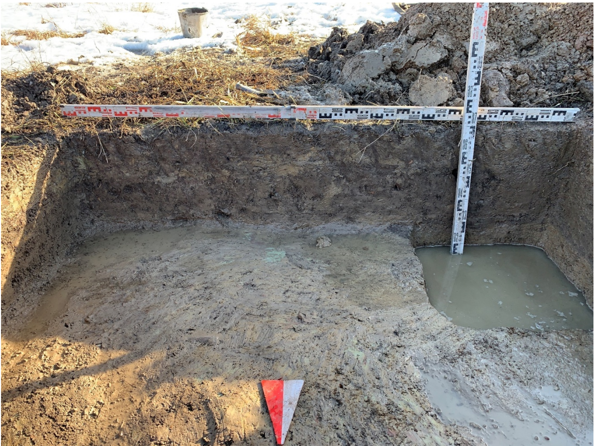
Рис. 29. Шушары, КН:78:42:1850206:6189-2023. Шурф 1, южная стенка.
