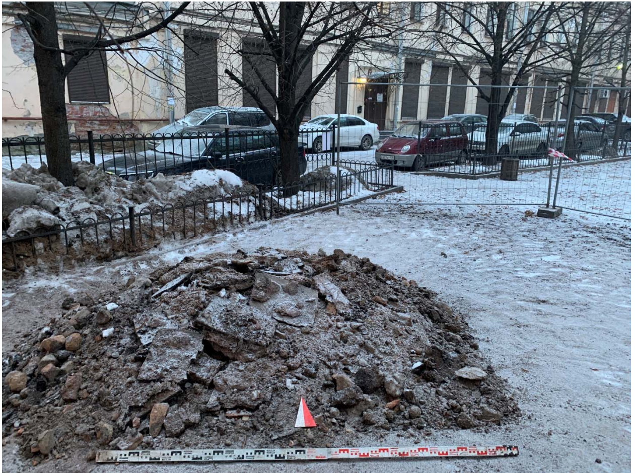
Рис. 45. СПб, Невский пр., д. 146-2023. Шурф 1 после рекультивации, вид на север.
