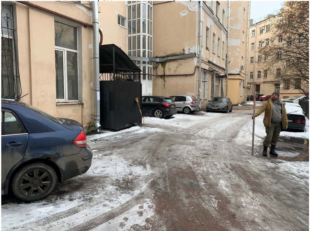
Рис. 12. СПб, Невский пр., д. 146-2023. Точка фотофиксации 2, вид на запад.
