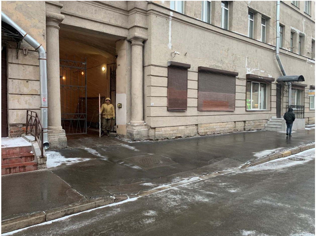
Рис. 19. СПб, Невский пр., д. 146-2023. Точка фотофиксации 6, вид на северо-запад.
