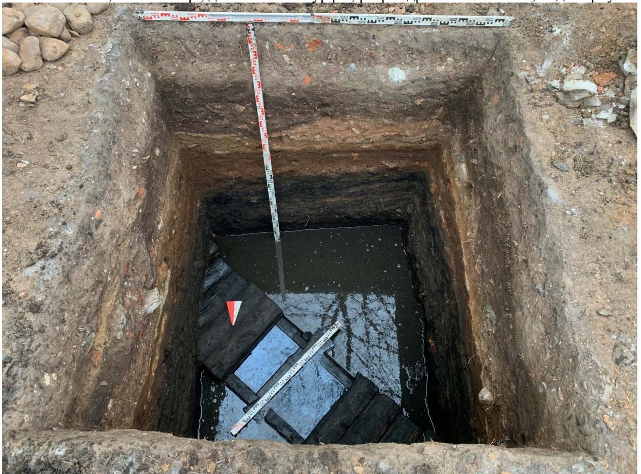
Рис. 36. СПб, Невский пр., д. 148-2023. Шурф 1, разрез дренажного лотка, вид сверху.
