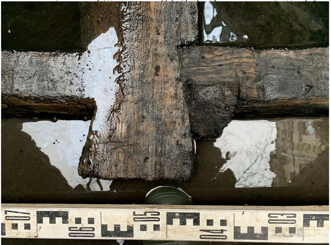
Рис. 32. СПб, Невский пр., д. 148-2023. Шурф 1, разрез дренажного лотка, вид сверху.
