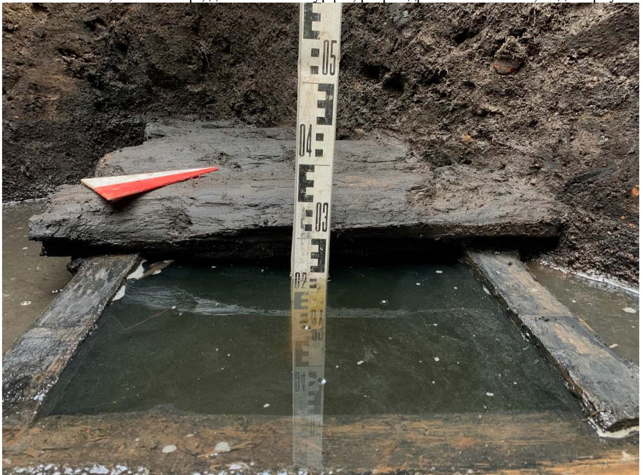
Рис. 34. СПб, Невский пр., д. 148-2023. Шурф 1, разрез дренажного лотка.
