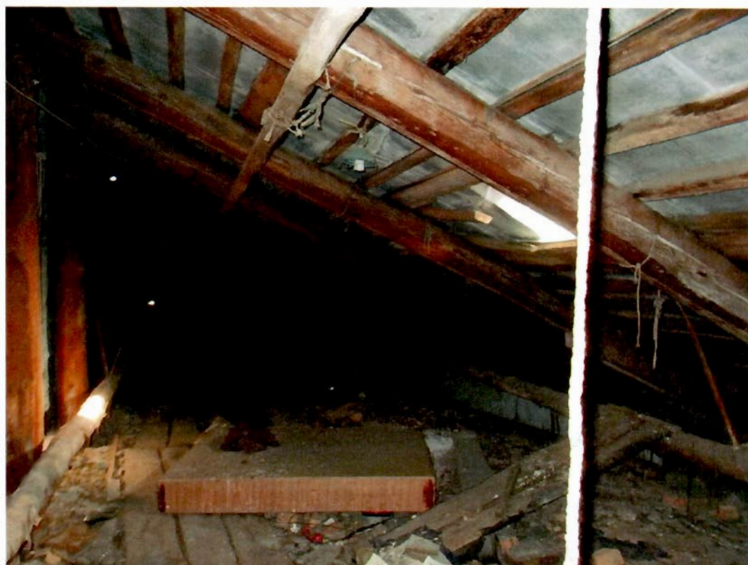
17. Чердак (стропильная система северного флигеля)
