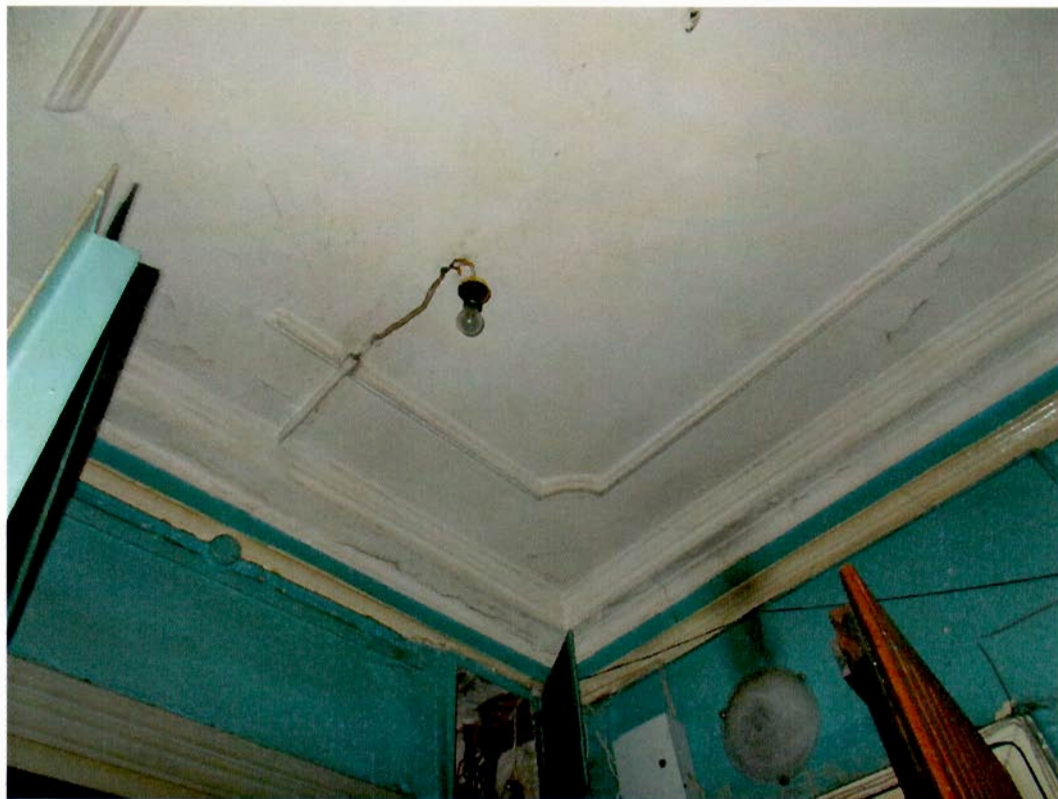
10. Интерьер (лестница Л-2 в уровне 2 этажа)
