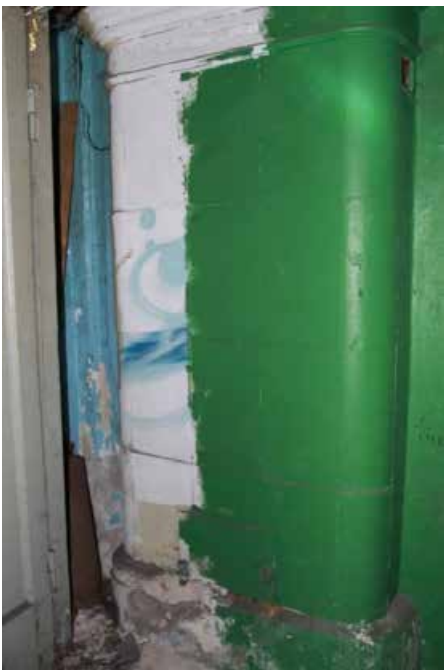
Фото 19. Объект культурного наследия регионального значения «Дом жилой И.Форша. Здесь в музыкальном салоне Ю.Ф.Абаза состоялось первое исполнение оперы П.И.Чайковского "Евгений Онегин"»: Санкт-Петербург, набережная реки Фонтанки, дом 23, литера А. Средистенная печь белого кафеля в тамбуре лестницы Л-2.
