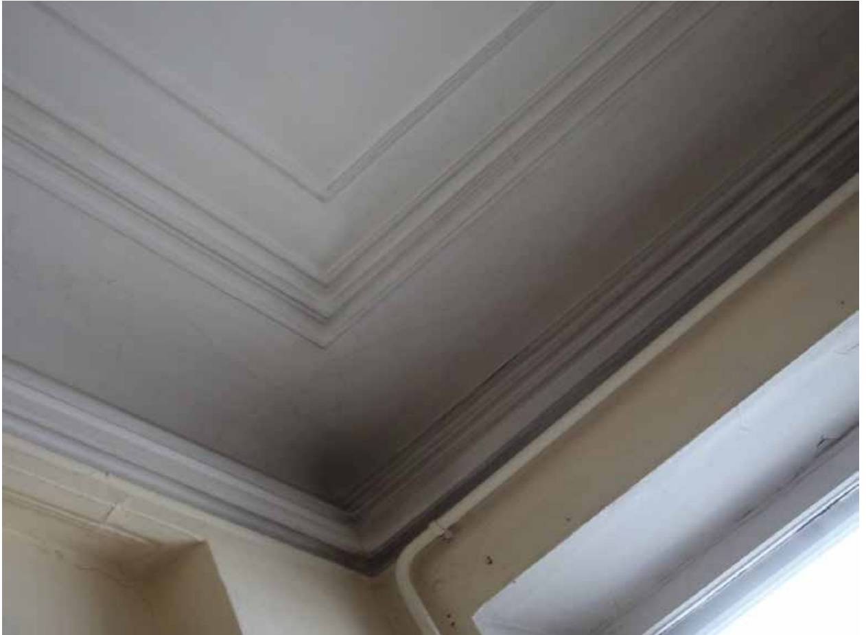
Фото 17. Объект культурного наследия регионального значения «Дом жилой И.Форша. Здесь в музыкальном салоне Ю.Ф.Абаза состоялось первое исполнение оперы П.И.Чайковского "Евгений Онегин"»: Санкт-Петербург, набережная реки Фонтанки, дом 23, литера А. Помещение 15Н. Исторический рисунок лепного декора в виде профилированной штукатурной рамы по периметру перекрытия.
