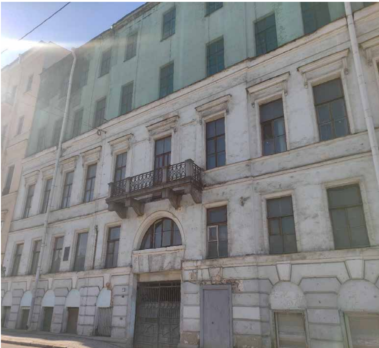
Фото 2. Объект культурного наследия регионального значения «Дом жилой И.Форша. Здесь в музыкальном салоне Ю.Ф.Абаза состоялось первое исполнение оперы П.И.Чайковского "Евгений Онегин"»: Санкт-Петербург, набережная реки Фонтанки, дом 23, литера А. Восточный фасад главного дома.
