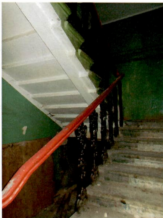
12. Интерьер (лестница Л-3 в уровне 1 этажа)
