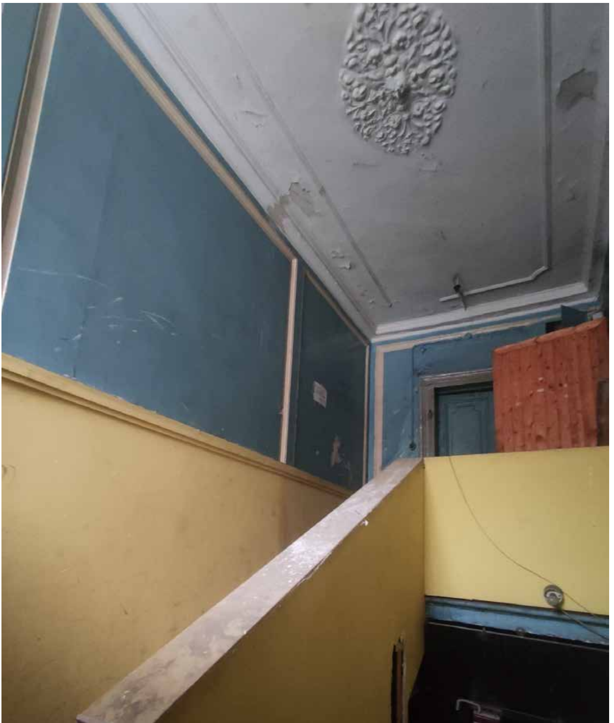
Фото 12. Объект культурного наследия регионального значения «Дом жилой И.Форша. Здесь в музыкальном салоне Ю.Ф.Абаза состоялось первое исполнение оперы П.И.Чайковского "Евгений Онегин"»: Санкт-Петербург, набережная реки Фонтанки, дом 23, литера А. Лестница Л-2, расположенная в главном доме: - профилированная штукатурная рама по периметру перекрытия; - лепная розетка растительного орнамента в центре перекрытия; - профилированные штукатурные филенки по стенам.
