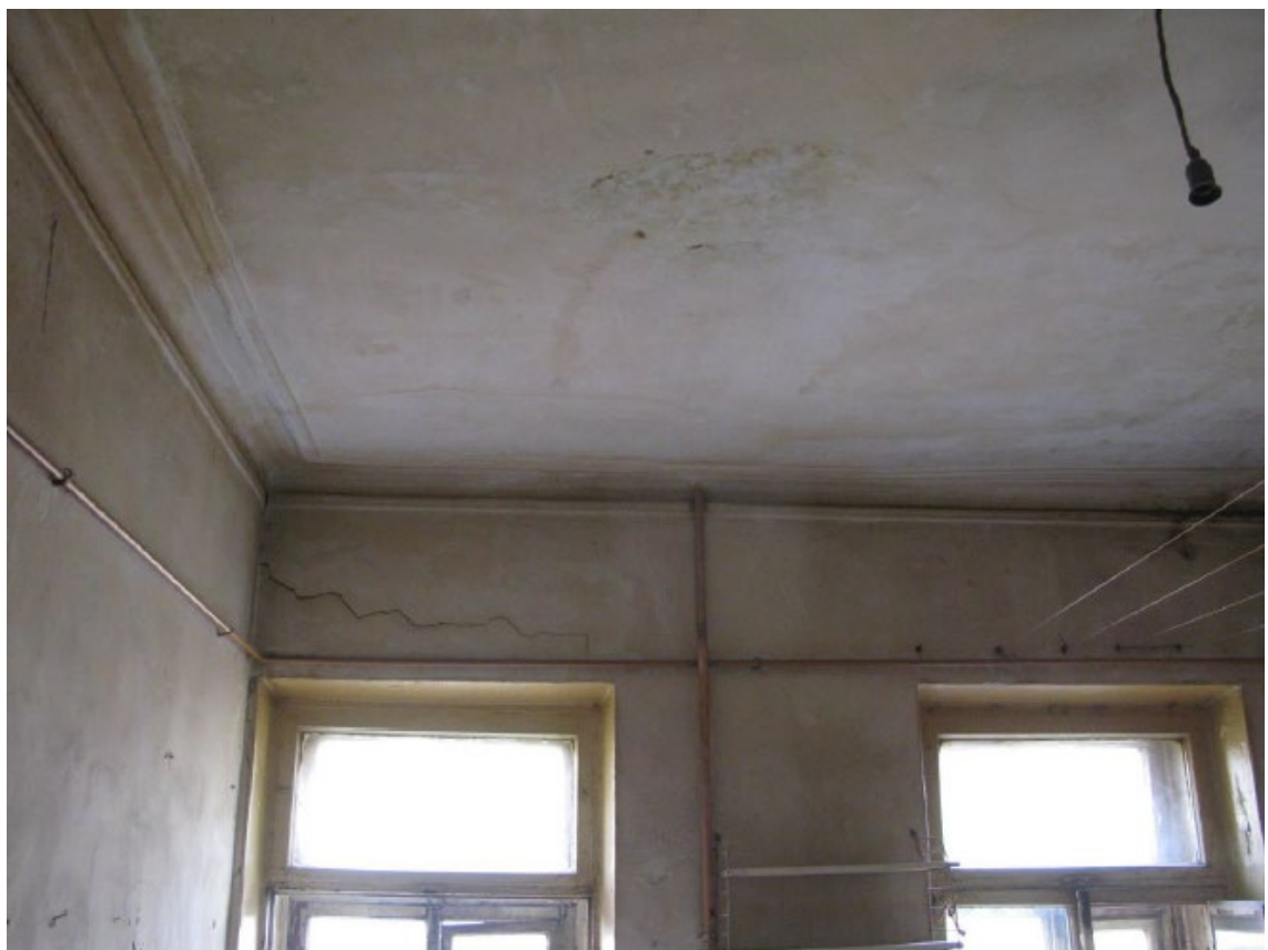
24. Помещение № 13 квартиры №13 в уровне 4-го этажа объекта культурного наследия федерального значения «Дом, где в 1887-1891 гг. жил композитор Рубинштейн А.Г. Здесь в 1905-1906 гг. проходили заседания ЦК РСДРП», расположенного по адресу: г. Санкт-Петербург, Загородный пр., д. 9, литера А. 15.09.2022
