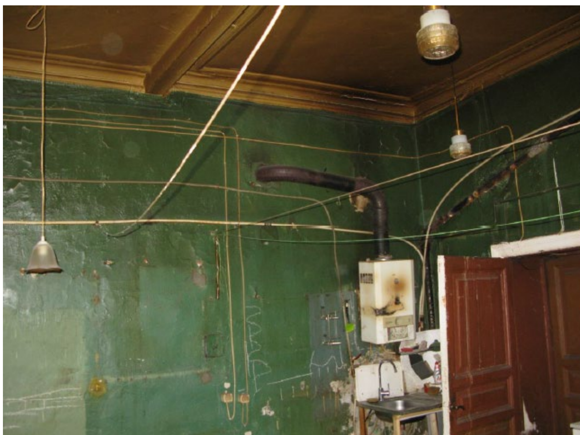
17. Помещение № 17 квартиры №14 в уровне 4-го этажа объекта культурного наследия федерального значения «Дом, где в 1887-1891 гг. жил композитор Рубинштейн А.Г. Здесь в 1905-1906 гг. проходили заседания ЦК РСДРП», расположенного по адресу: г. Санкт-Петербург, Загородный пр., д. 9, литера А. 15.09.2022
