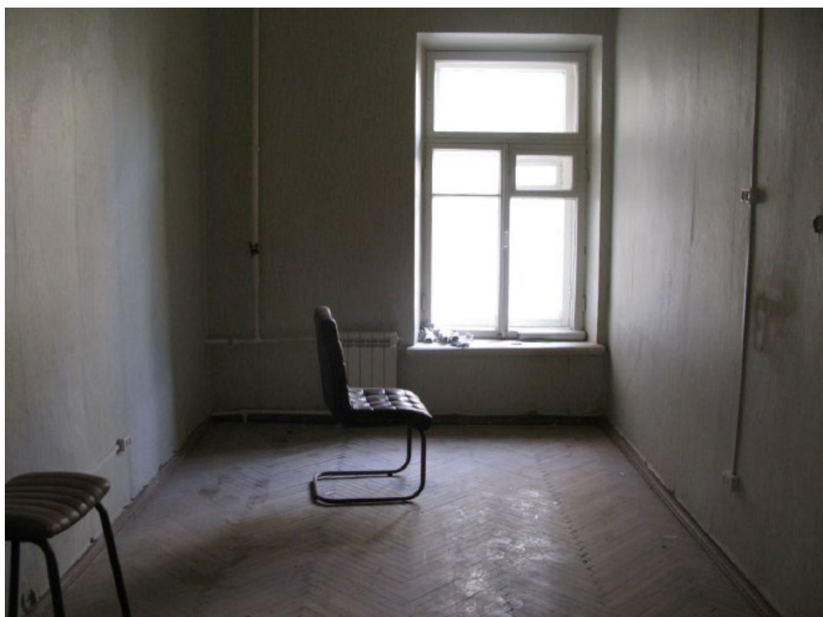
13. Помещение № 13 квартиры №14 в уровне 4-го этажа объекта культурного наследия федерального значения «Дом, где в 1887-1891 гг. жил композитор Рубинштейн А.Г. Здесь в 1905-1906 гг. проходили заседания ЦК РСДРП», расположенного по адресу: г. Санкт-Петербург, Загородный пр., д. 9, литера А. 15.09.2022
