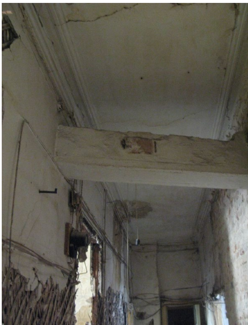
27. Помещение № 9 квартиры №13 в уровне 4-го этажа объекта культурного наследия федерального значения «Дом, где в 1887-1891 гг. жил композитор Рубинштейн А.Г. Здесь в 1905-1906 гг. проходили заседания ЦК РСДРП», расположенного по адресу: г. Санкт-Петербург, Загородный пр., д. 9, литера А. 15.09.2022
