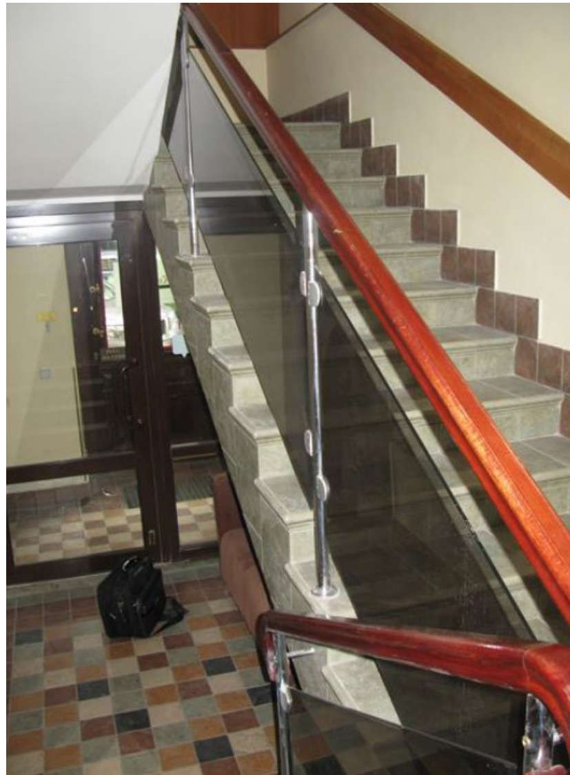
31. Лестничная клетка помещения 30-Н в уровне 1-го этажа объекта культурного наследия федерального значения «Дом, где в 1887-1891 гг. жил композитор Рубинштейн А.Г. Здесь в 1905-1906 гг. проходили заседания ЦК РСДРП», расположенного по адресу: г. Санкт-Петербург, Загородный пр., д. 9, литера А. 15.09.2022
