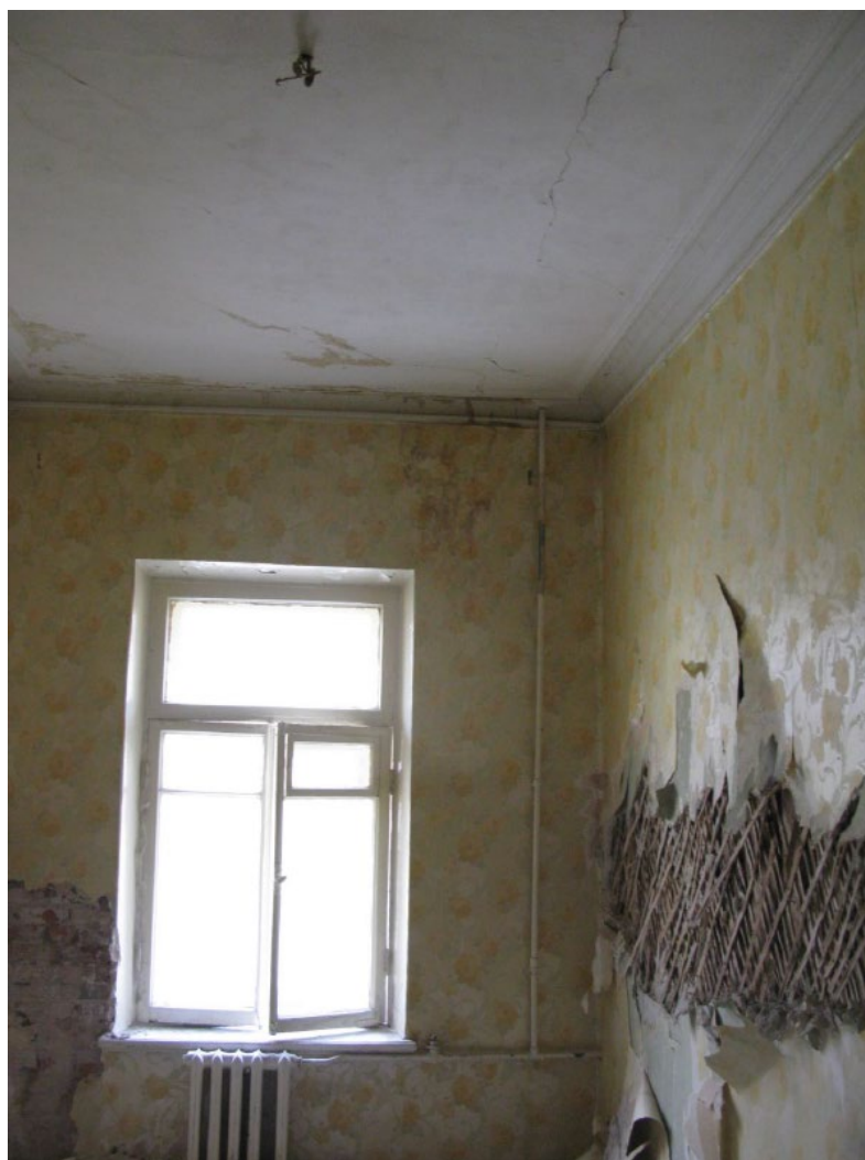
26. Помещение № 11 квартиры №13 в уровне 4-го этажа объекта культурного наследия федерального значения «Дом, где в 1887-1891 гг. жил композитор Рубинштейн А.Г. Здесь в 1905-1906 гг. проходили заседания ЦК РСДРП», расположенного по адресу: г. Санкт-Петербург, Загородный пр., д. 9, литера А. 15.09.2022
