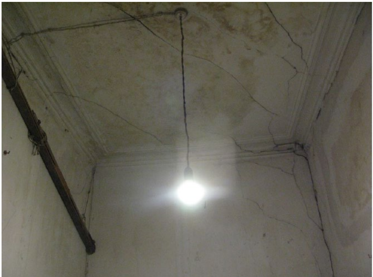
16. Помещение № 14 квартиры №14 в уровне 4-го этажа объекта культурного наследия федерального значения «Дом, где в 1887-1891 гг. жил композитор Рубинштейн А.Г. Здесь в 1905-1906 гг. проходили заседания ЦК РСДРП», расположенного по адресу: г. Санкт-Петербург, Загородный пр., д. 9, литера А. 15.09.2022
