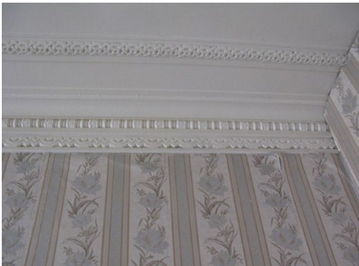
22. Помещение № 15 квартиры №13 в уровне 4-го этажа объекта культурного наследия федерального значения «Дом, где в 1887-1891 гг. жил композитор Рубинштейн А.Г. Здесь в 1905-1906 гг. проходили заседания ЦК РСДРП», расположенного по адресу: г. Санкт-Петербург, Загородный пр., д. 9, литера А. 15.09.2022
