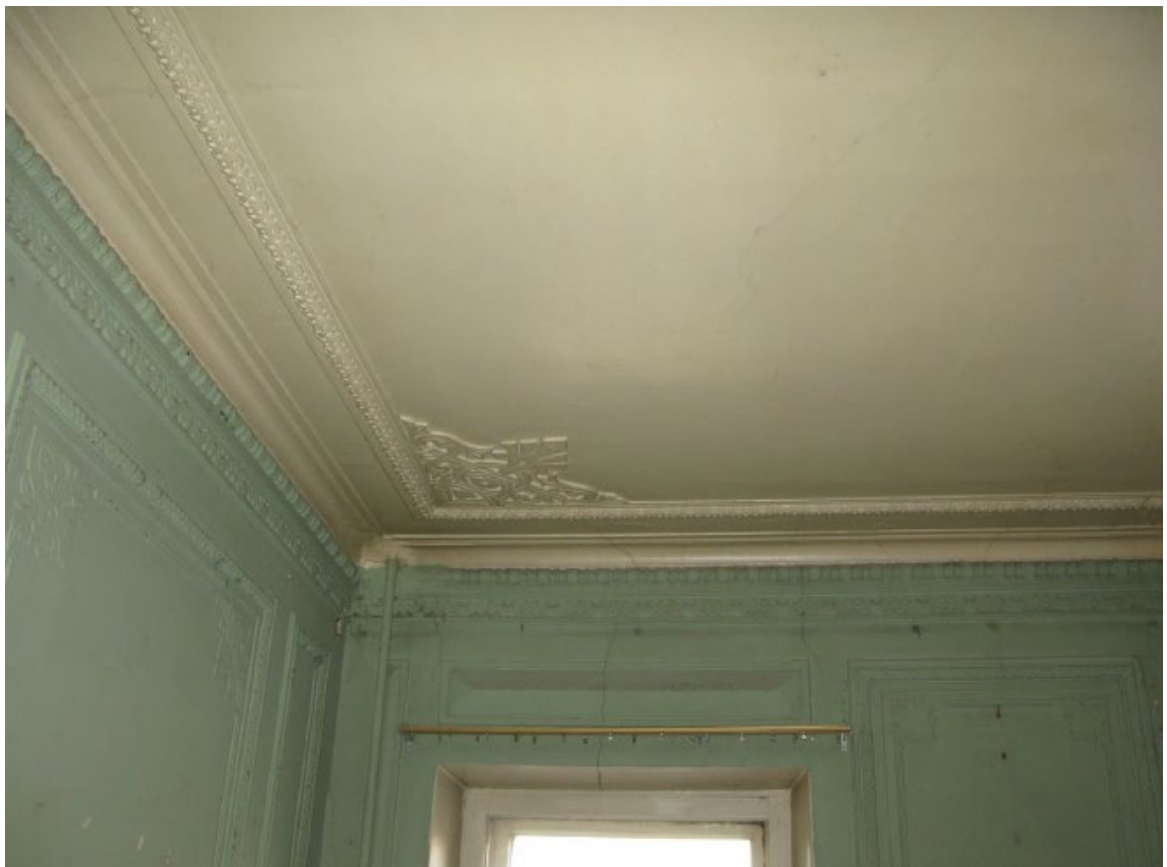
9. Помещение № 10 квартиры №14 в уровне 4-го этажа объекта культурного наследия федерального значения «Дом, где в 1887-1891 гг. жил композитор Рубинштейн А.Г. Здесь в 1905-1906 гг. проходили заседания ЦК РСДРП», расположенного по адресу: г. Санкт-Петербург, Загородный пр., д. 9, литера А. 15.09.2022
