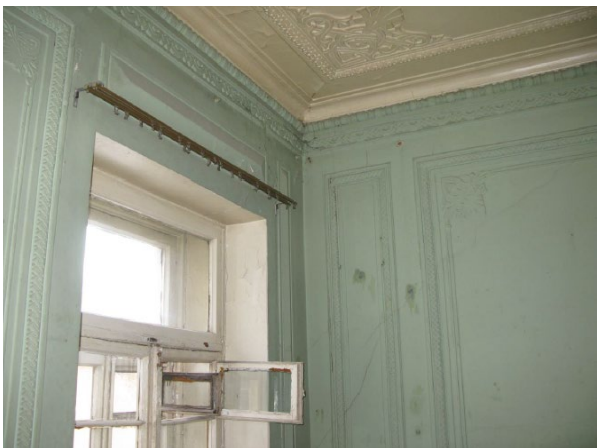
10. Помещение № 10 квартиры №14 в уровне 4-го этажа объекта культурного наследия федерального значения «Дом, где в 1887-1891 гг. жил композитор Рубинштейн А.Г. Здесь в 1905-1906 гг. проходили заседания ЦК РСДРП», расположенного по адресу: г. Санкт-Петербург, Загородный пр., д. 9, литера А. 15.09.2022
