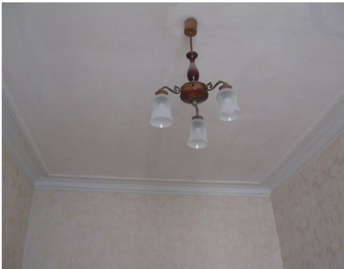
15. Помещение № 11 квартиры №14 в уровне 4-го этажа объекта культурного наследия федерального значения «Дом, где в 1887-1891 гг. жил композитор Рубинштейн А.Г. Здесь в 1905-1906 гг. проходили заседания ЦК РСДРП», расположенного по адресу: г. Санкт-Петербург, Загородный пр., д. 9, литера А. 15.09.2022
