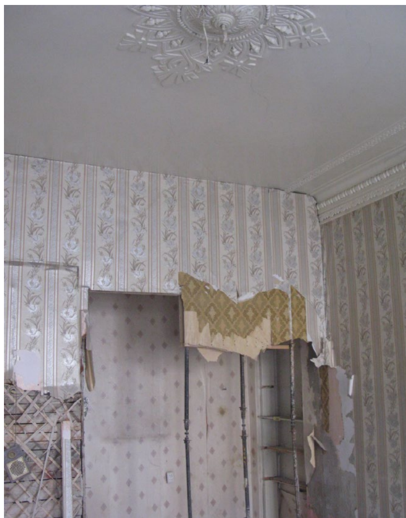
19. Помещение № 15 квартиры №13 в уровне 4-го этажа объекта культурного наследия федерального значения «Дом, где в 1887-1891 гг. жил композитор Рубинштейн А.Г. Здесь в 1905-1906 гг. проходили заседания ЦК РСДРП», расположенного по адресу: г. Санкт-Петербург, Загородный пр., д. 9, литера А. 15.09.2022
