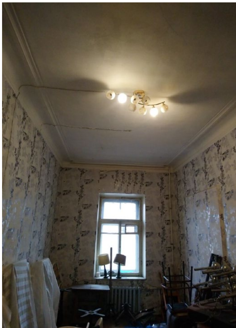
28. Помещение №5 квартиры №13 в уровне 4-го этажа объекта культурного наследия федерального значения «Дом, где в 1887-1891 гг. жил композитор Рубинштейн А.Г. Здесь в 1905-1906 гг. проходили заседания ЦК РСДРП», расположенного по адресу: г. Санкт-Петербург, Загородный пр., д. 9, литера А. 15.09.2022
