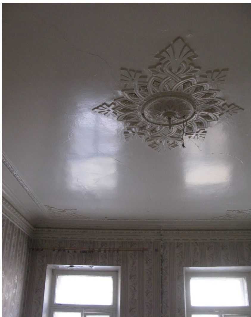
20. Помещение № 15 квартиры №13 в уровне 4-го этажа объекта культурного наследия федерального значения «Дом, где в 1887-1891 гг. жил композитор Рубинштейн А.Г. Здесь в 1905-1906 гг. проходили заседания ЦК РСДРП», расположенного по адресу: г. Санкт-Петербург, Загородный пр., д. 9, литера А. 15.09.2022
