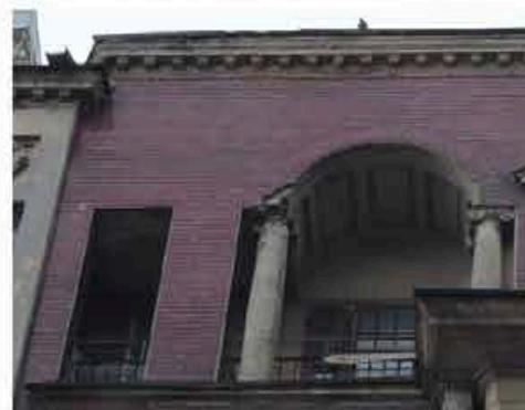
угловые лоджии в уровне 5-го этажа фасадов курдонера – с массивной колонной и полуколоннами с поясом иоников в капителях, с ограждением в виде оштукатуренных опорных тумб, завершенных сферами, и металлических секций;\*
