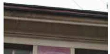
венчающий профилированный карниз с «сухариками» - в части угловой башни и шипцов;
