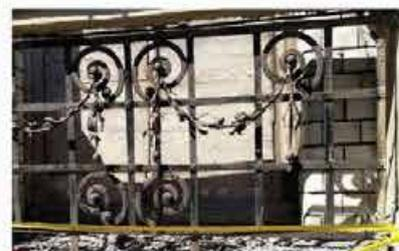
французские балконы на орнаментированных кронштейнах, в одну световую ось в уровне 4-го этажа угловых частей северного фасада и курдонера, с ограждением в виде оштукатуренных опорных тумб, завершенных сферами, и металлических секций;\*
