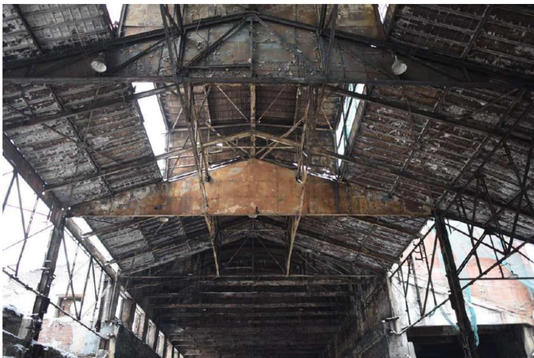
Фото 7. Интерьер. Конструкции светового фонаря.
