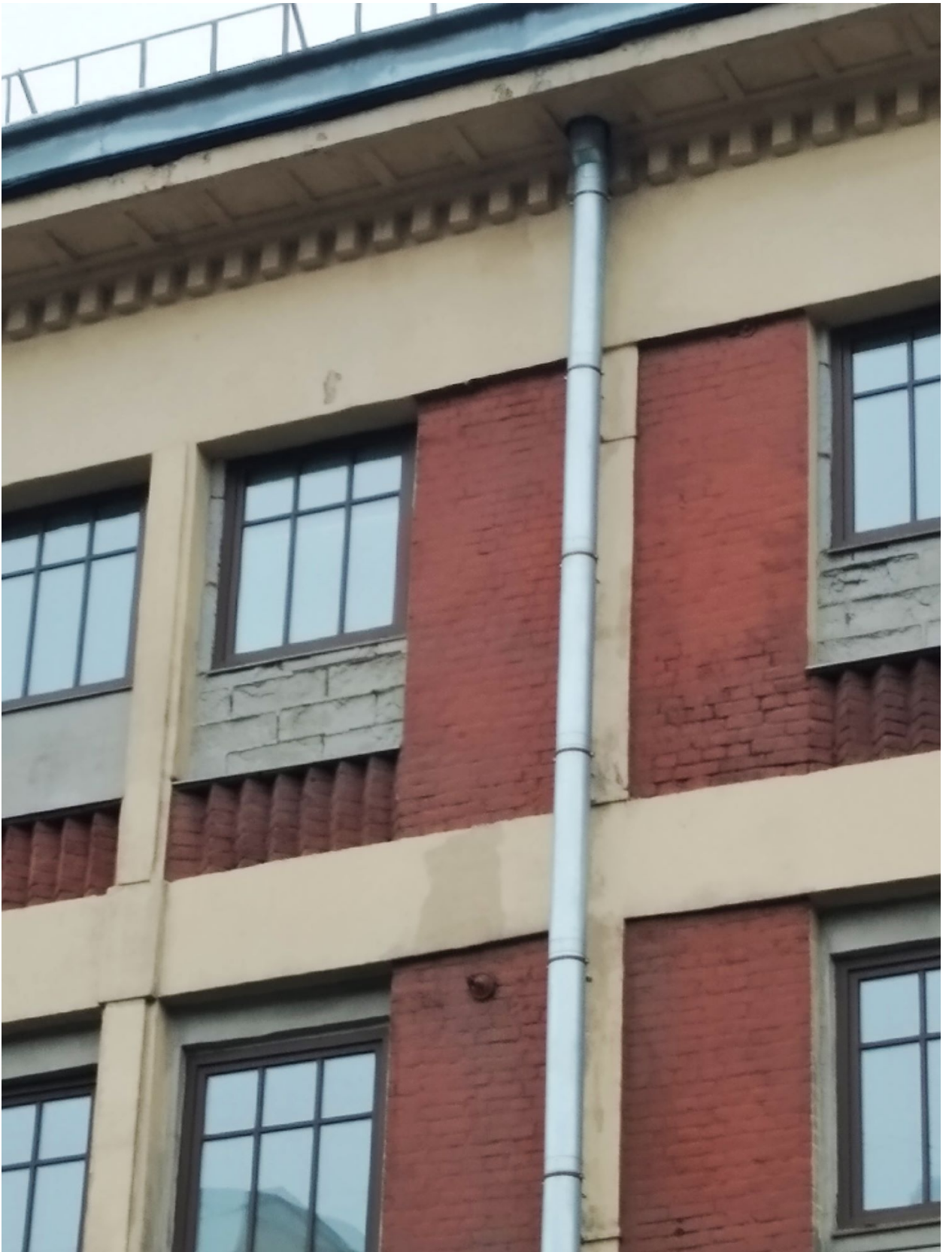
Фото 6. Фрагмент восточного фасада по Б. Сампсониевскому пр. Железобетонный каркас, заполнения межкаркасного пространства красным кирпичем и витражными проемами, частично заложены. Венчающий карниз на консольной плите.
