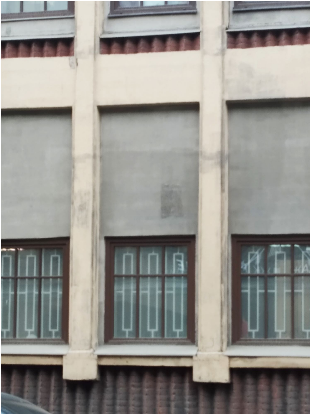
Фото 5. Фрагмент восточного фасада по Б. Сампсониевскому пр. Частично заложенные витражные заполнения 1-го этажа.
