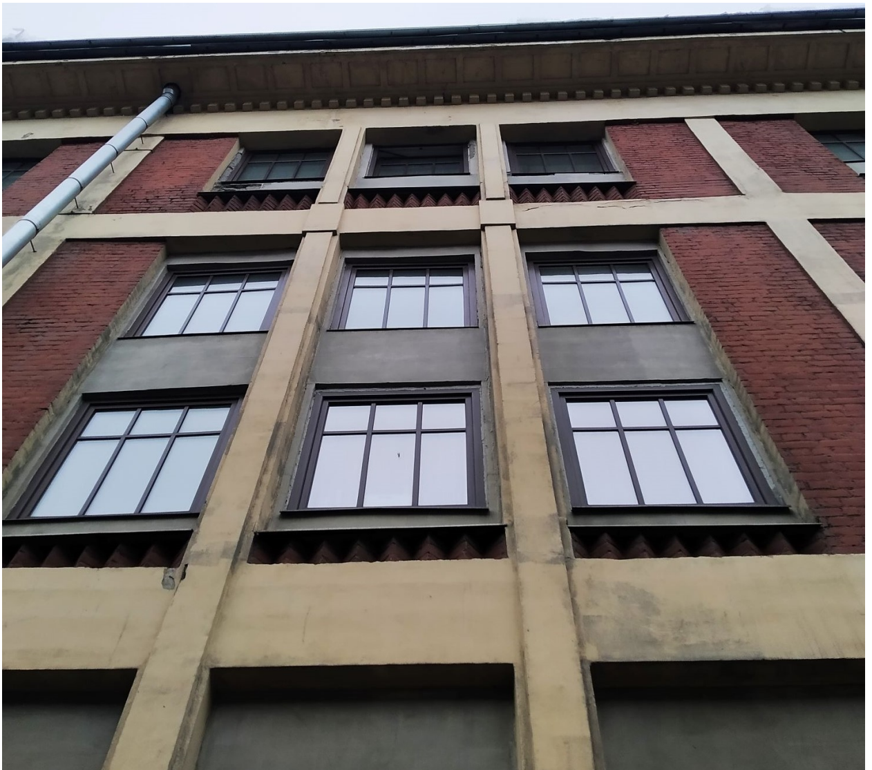
Фото 3. Фрагмент восточного фасада по Б. Сампсониевскому пр. Железобетонный каркас, заполнения межкаркасного пространства красным кирпичем и витражными проемами.
