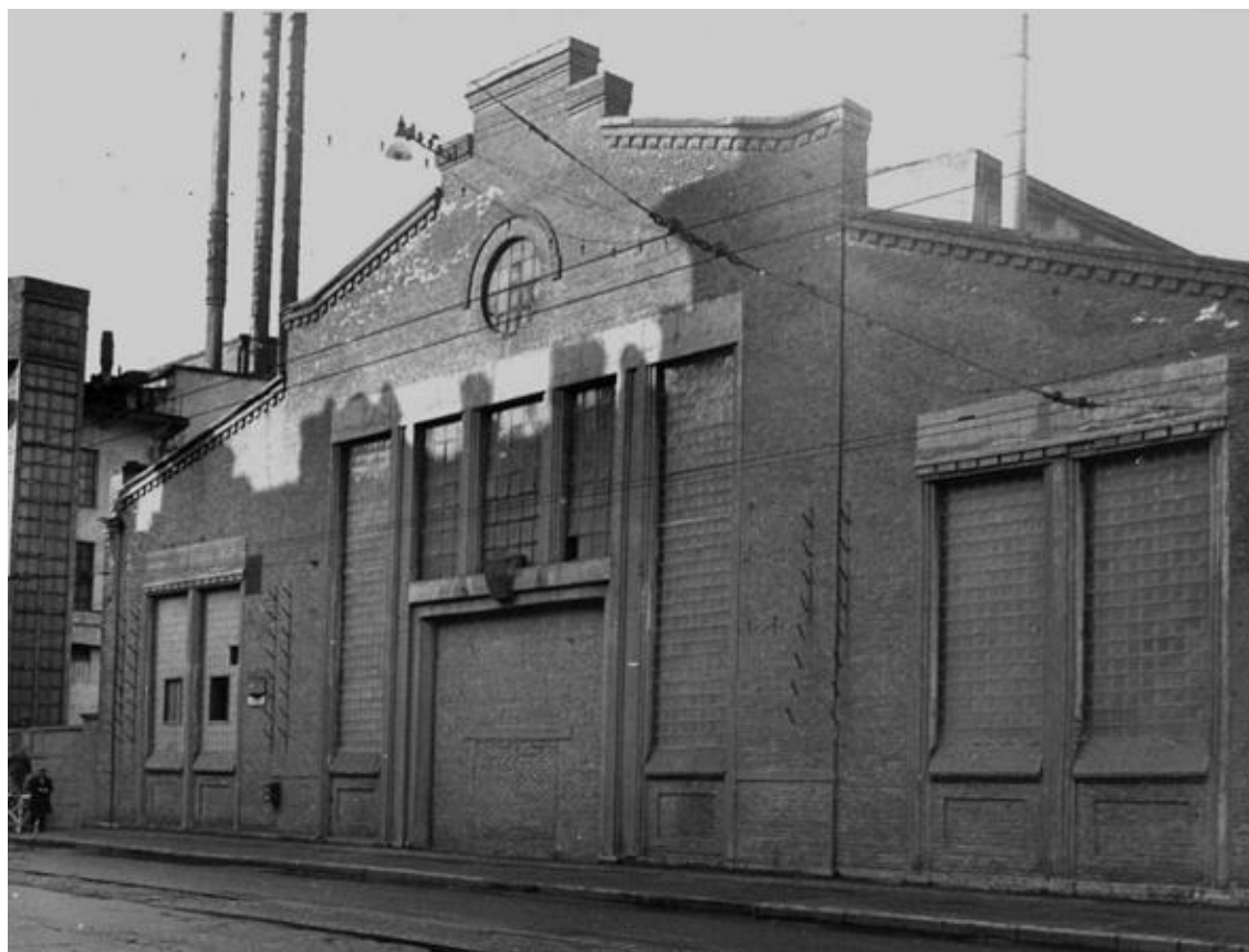
Илл. 38. Чугунолитейный цех. Фасад по Большому Сампсониевскому проспекту. Фото 1970-х гг. Сектор хранения документированной информации КГИОП.
