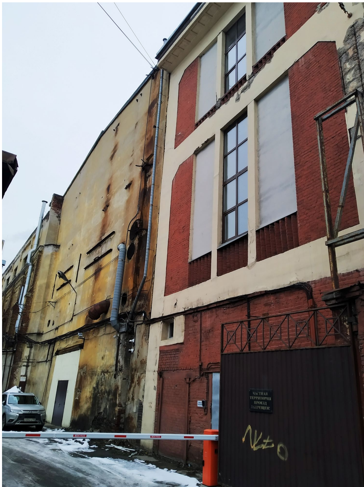
Фото 4. Южный фасад. Железобетонный каркас, заполнения межкаркасного пространства красным кирпичем и витражными проемами, частично заложеными.
