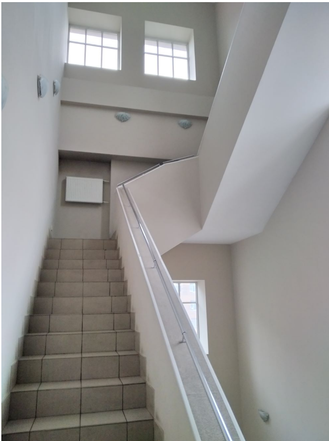
Фото 7. Интерьер. Историческая лестница в пом. №№ 56, 156, 197.
