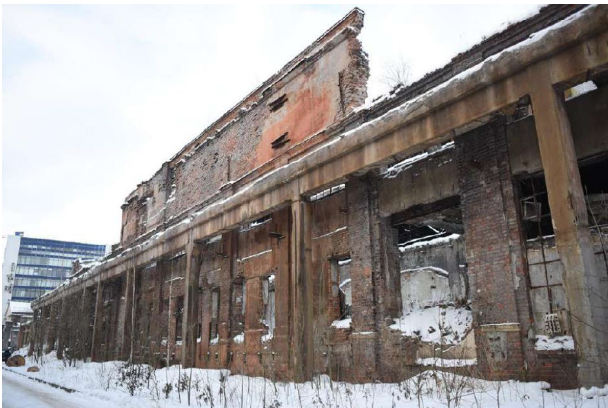
Фото 3. Фрагмент южного фасада со стороны внутривортовой территории.
