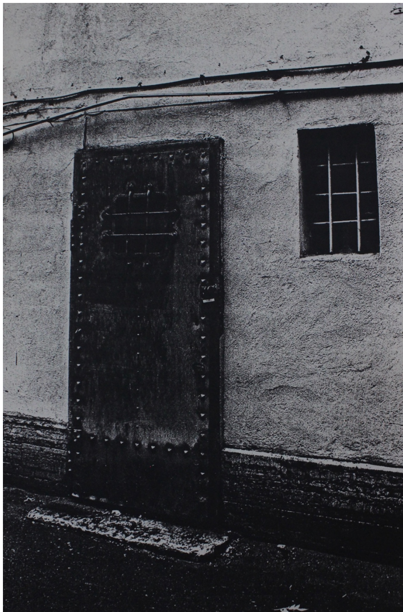
33. Дворовый фасад. Дверь входа в подвальные помещения. 1996 г. Сектор хранения документированной информации Управления организационного обеспечения и контроля КГИОП. Н-7141/1. С. 81
