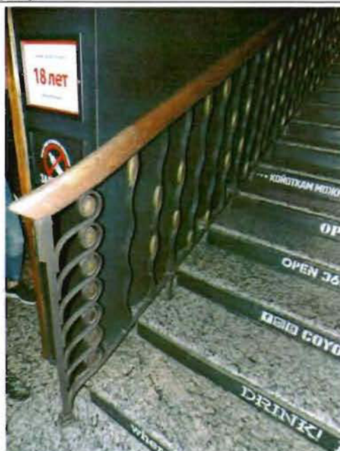
8. Ограждение парадной лестницы
