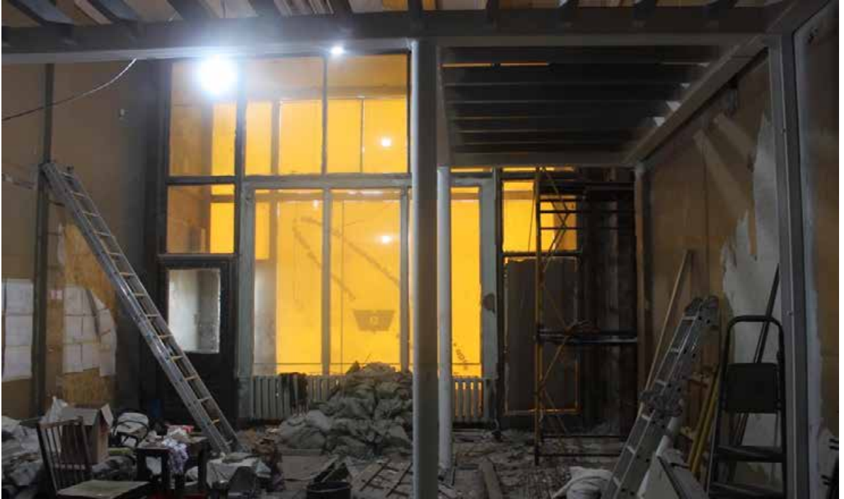
14. Общий вид помещения 22-Н в уровне 1 этажа в здании по адресу: СПб, Литейный пр. 57., Лит. Б
