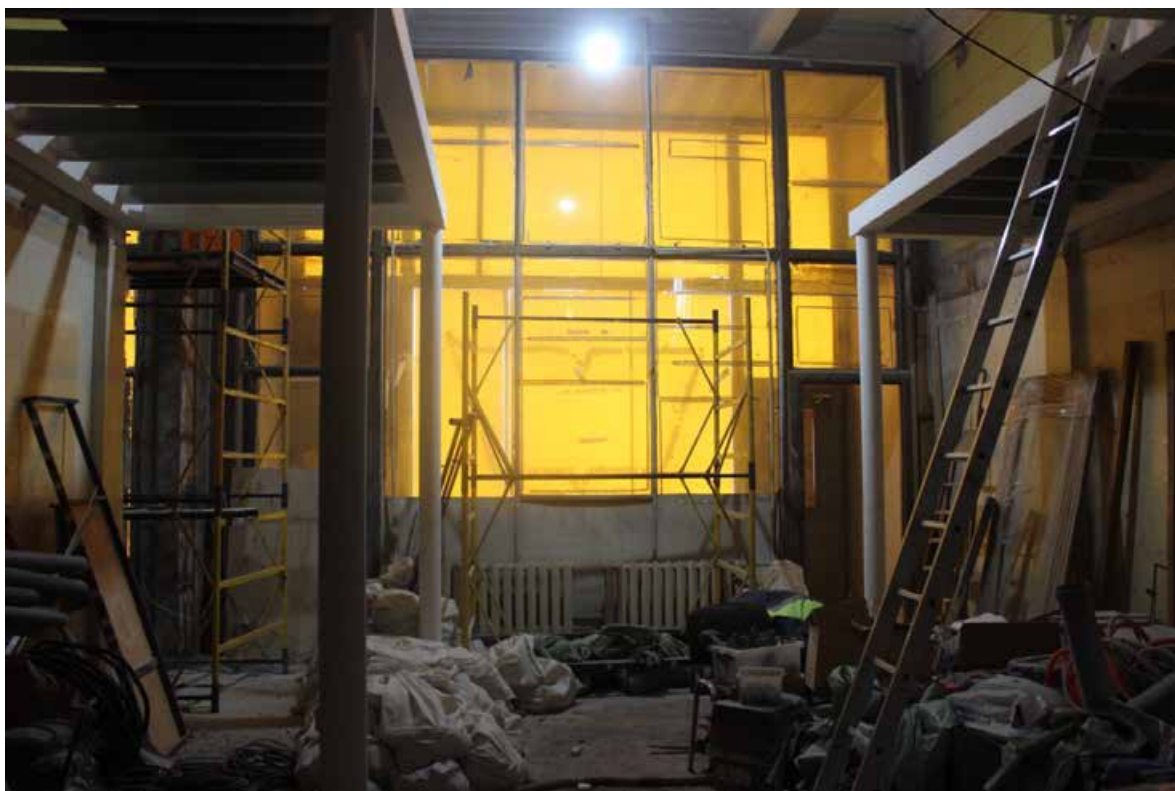
15. Общий вид помещения 22-Н в уровне 1 этажа в здании по адресу: СПб, Литейный пр. 57., Лит. Б
