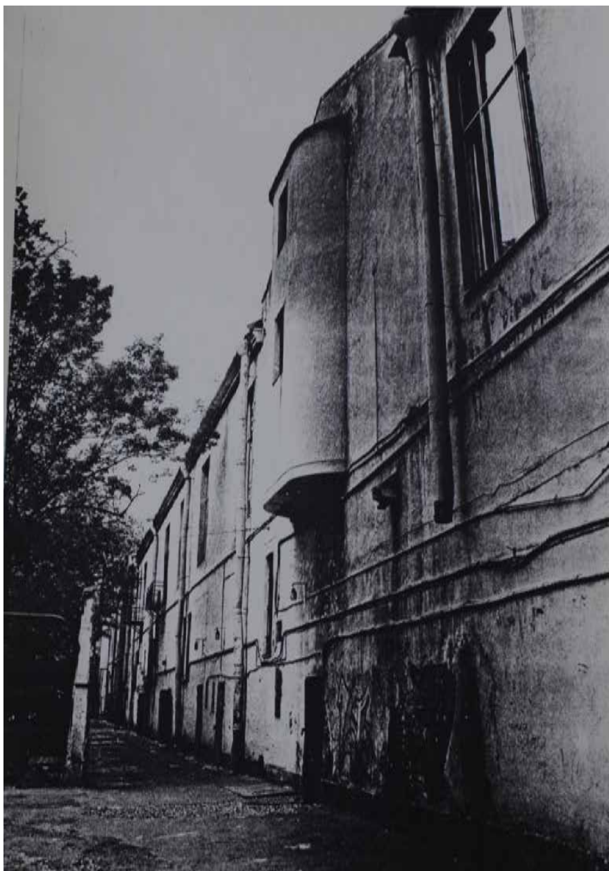
32. Дворовый фасад торговых рядов «Новый Пассаж». 1996 г. Сектор хранения документированной информации Управления организационного обеспечения и контроля КГИОП. Н-7141/1. С. 80
