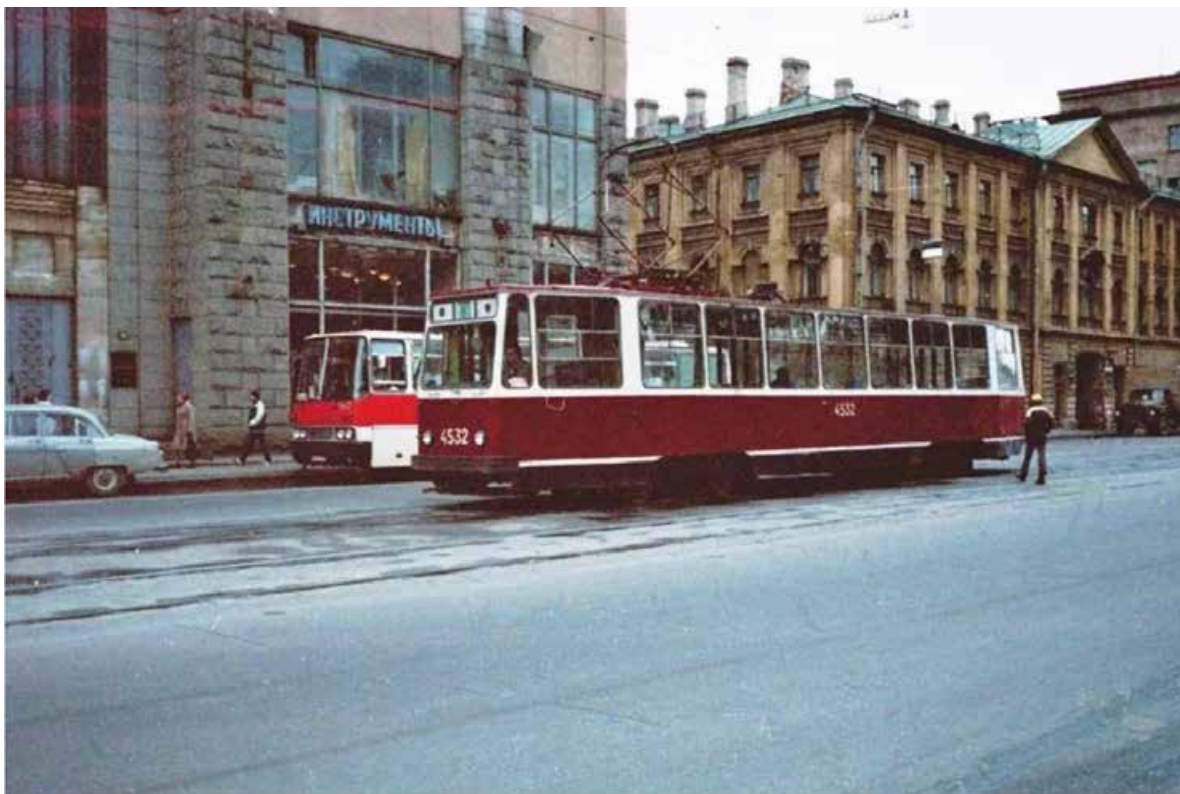
27. Фрагмент здания по адресу: Санкт-Петербург, Литейный проспект, 57. 1985 г. https://pastvu.com/p/327638
