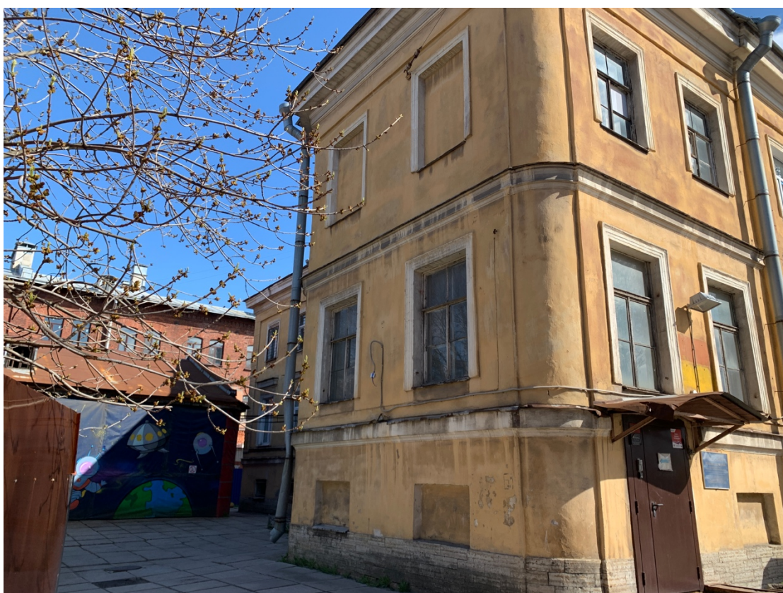
Фото 2. Общий вид дворовых фасадов.
