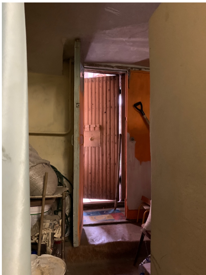
Фото 31. Фрагмент помещения №12 по плану ПИБ. Выход на улицу.
