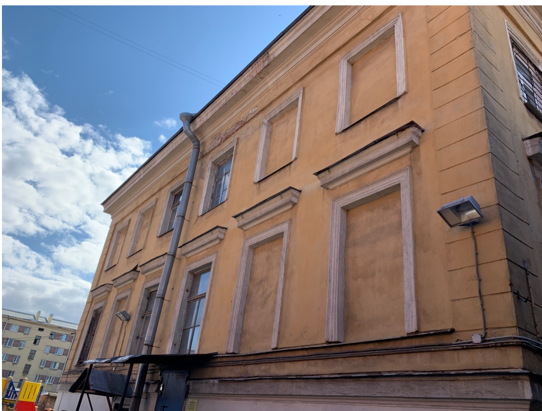
Фото 6. Общий вид фасада в осях В-А.
