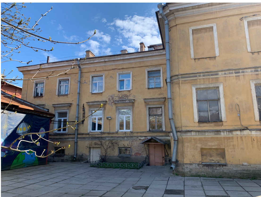
Фото 4. Общий вид дворовых фасадов
