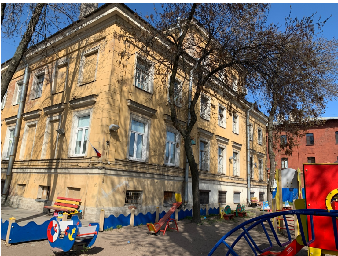
Фото 8. Общий вид фасада в осях 5-1
