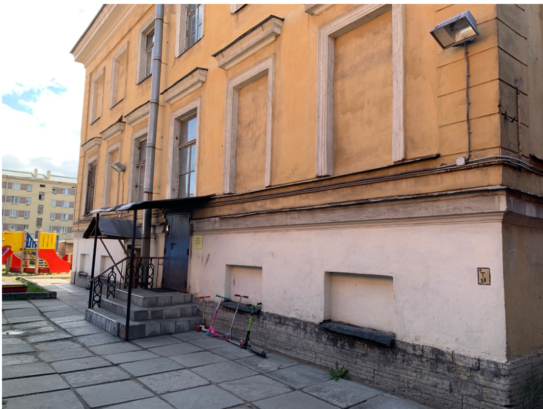
Фото 5. Общий вид фасада в осях В-А
