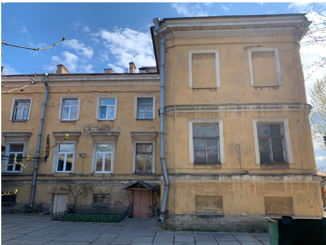
Фото 3. Общий вид дворовых фасадов
