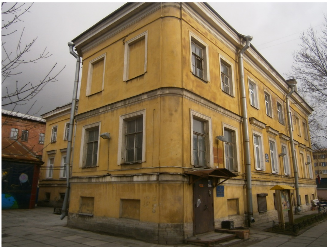
30. Вид на здание с северо-запада, фото апрель 2016 г. https://www.citywalls.ru/
