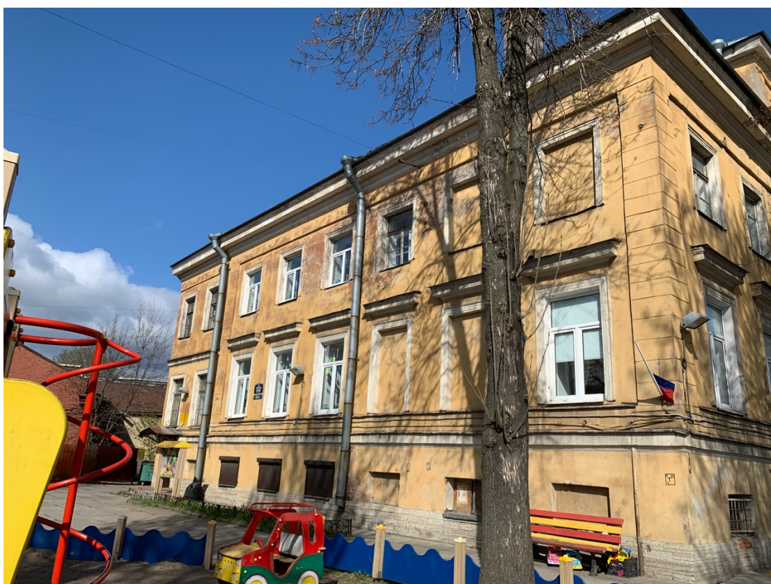
Фото 10. Общий вид фасада в осях А-І
