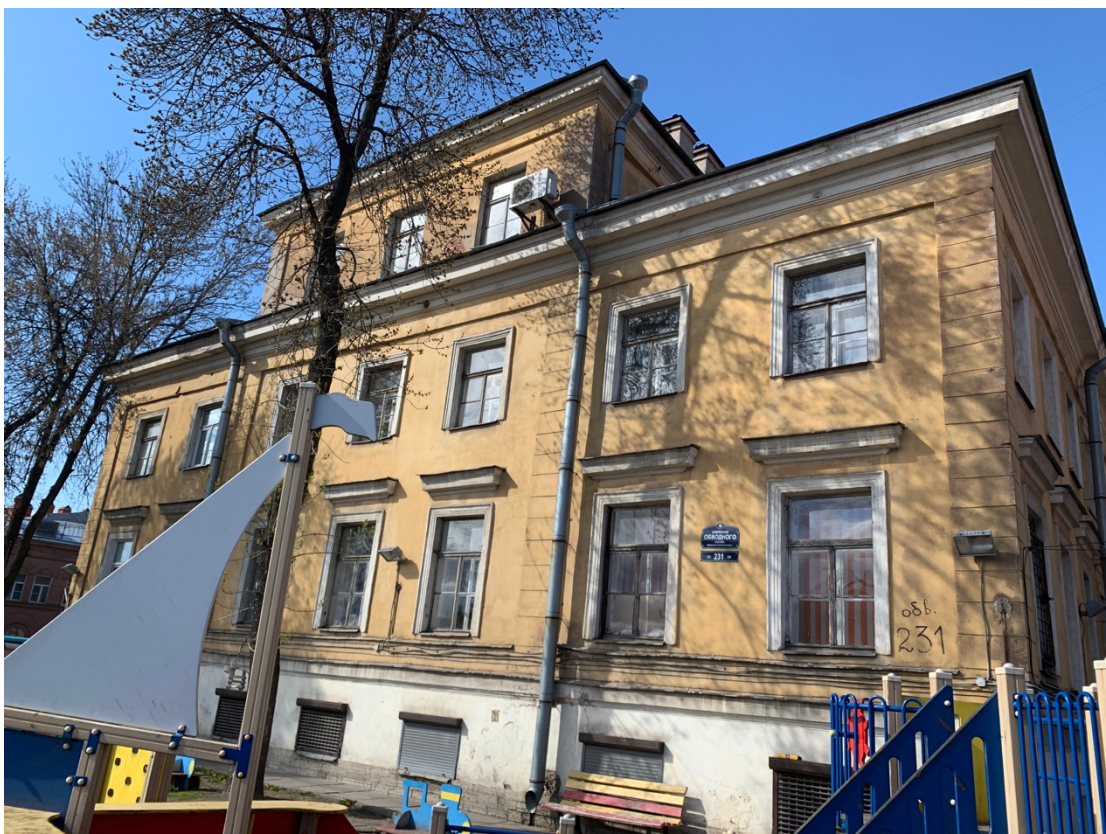
Фото 7. Общий вид фасада в осях 5-1
