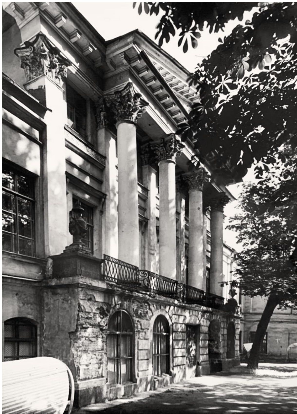
19. Архив КГИОП. Инв. №12591/3. Особняк Бобринских. Лицевой фасад со стороны парка. 1980-е гг.
