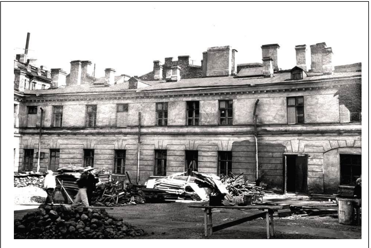
16. Архив КГИОП. Инв. №74025. Особняк Бобринских. Западный флигель дворового фасада до реставрации. 1960 г.
