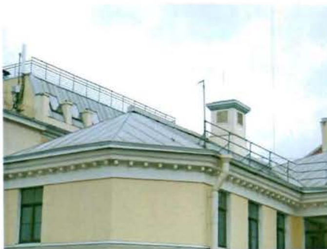
8. Металлическое покрытие кровли
