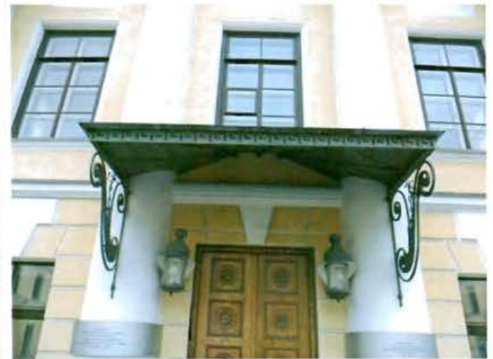
9. Кованый козырек на кронштейнах над входом
