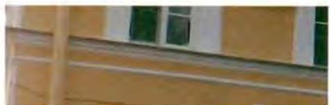
надоконная профилированная штукатурная тяга с металлическимкрытием в уровне второго этажа;
