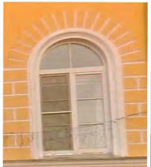
надоконная профилированная штукатурная тяга с металлическим покрытием в уровне второго этажа;
