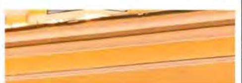
профилированный ступенчатый венчающий карниз с металлическим покрытием и штукатурной тягой в основании;
