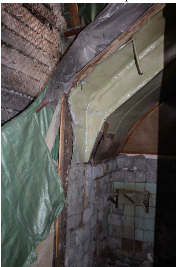
Фото 42. Фрагмент косоуров лестницы и помещения под ней.
