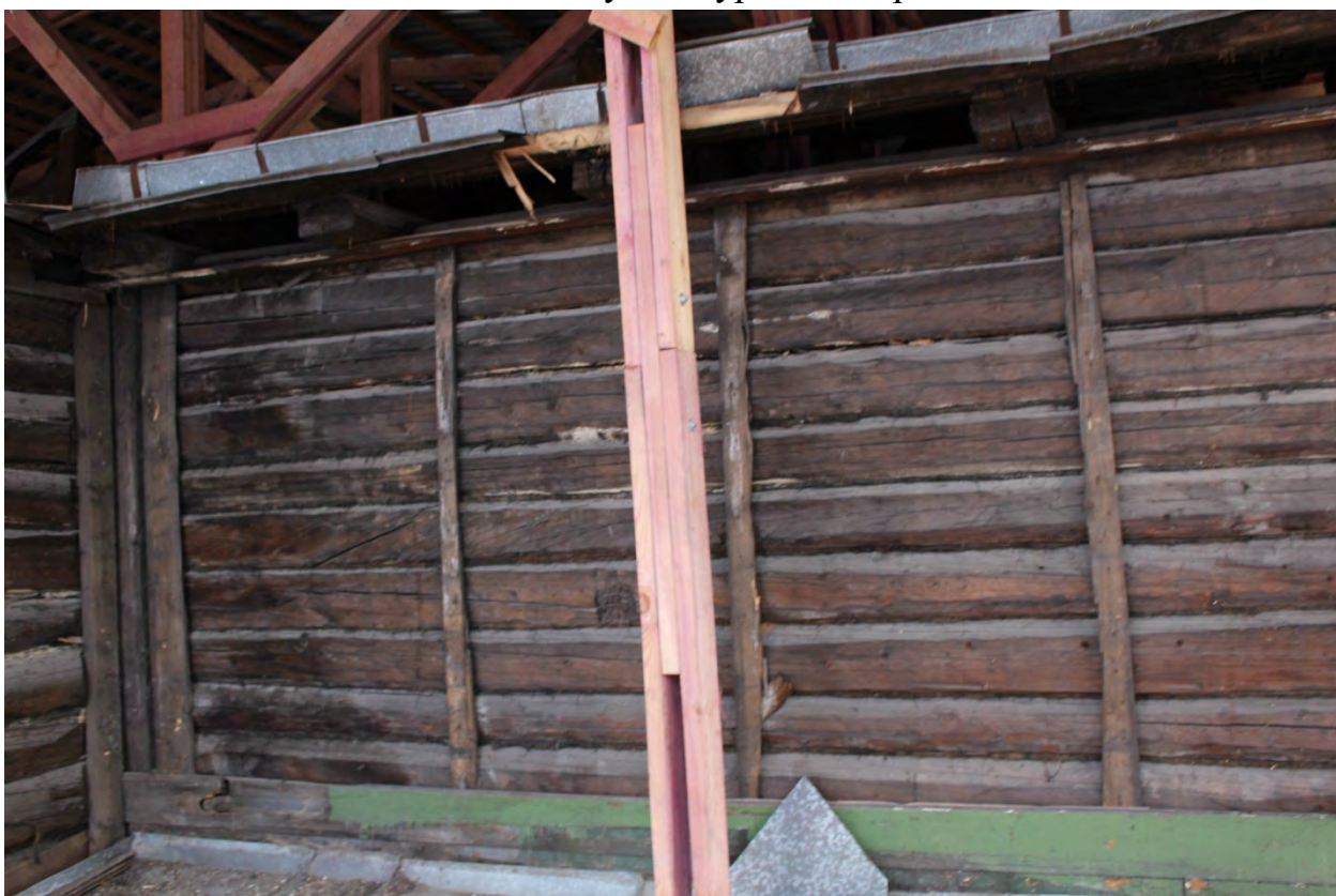
Фото 68. Вид на северную стену лицевого мезонина.
