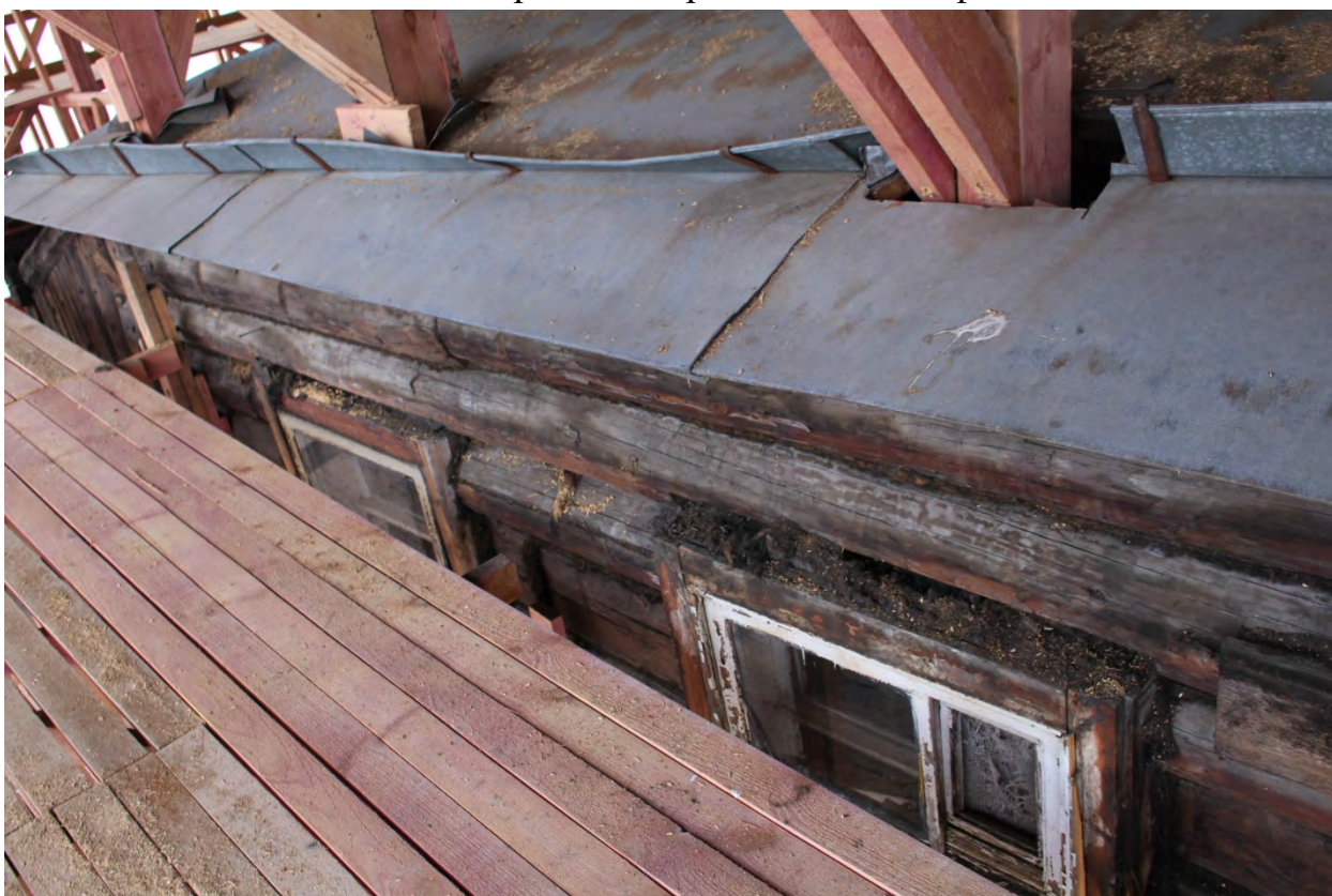
Фото 76. Вид на юго-восточный карниз.
