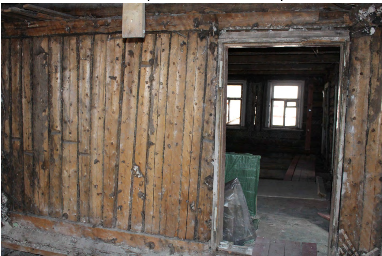
Фото 44. Вид на вход в юго-восточные помещения второго этажа.
