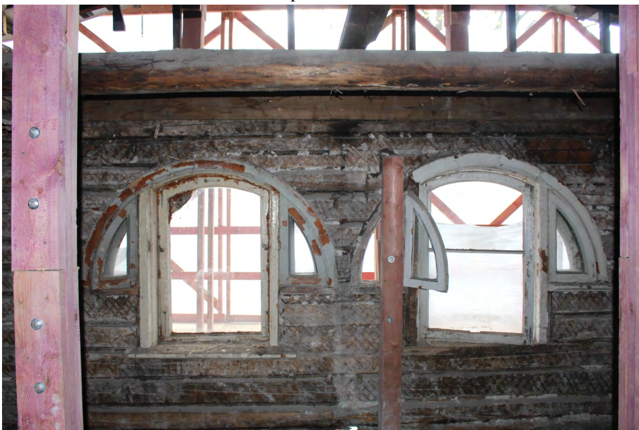
Фото 48. Оконные проемы лицевого фасада второго этажа.
