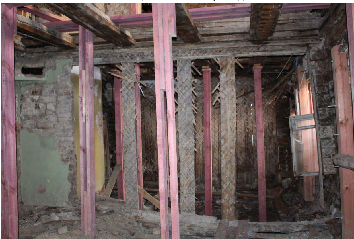
Фото 38. Вид на юго-восточные помещения.
