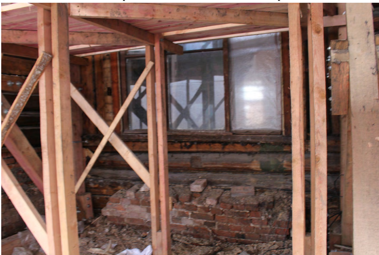
Фото 12. Центральная часть юго-восточного фасада.
