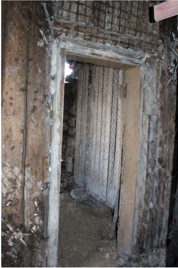
Фото 23. Вид в северное помещение.
