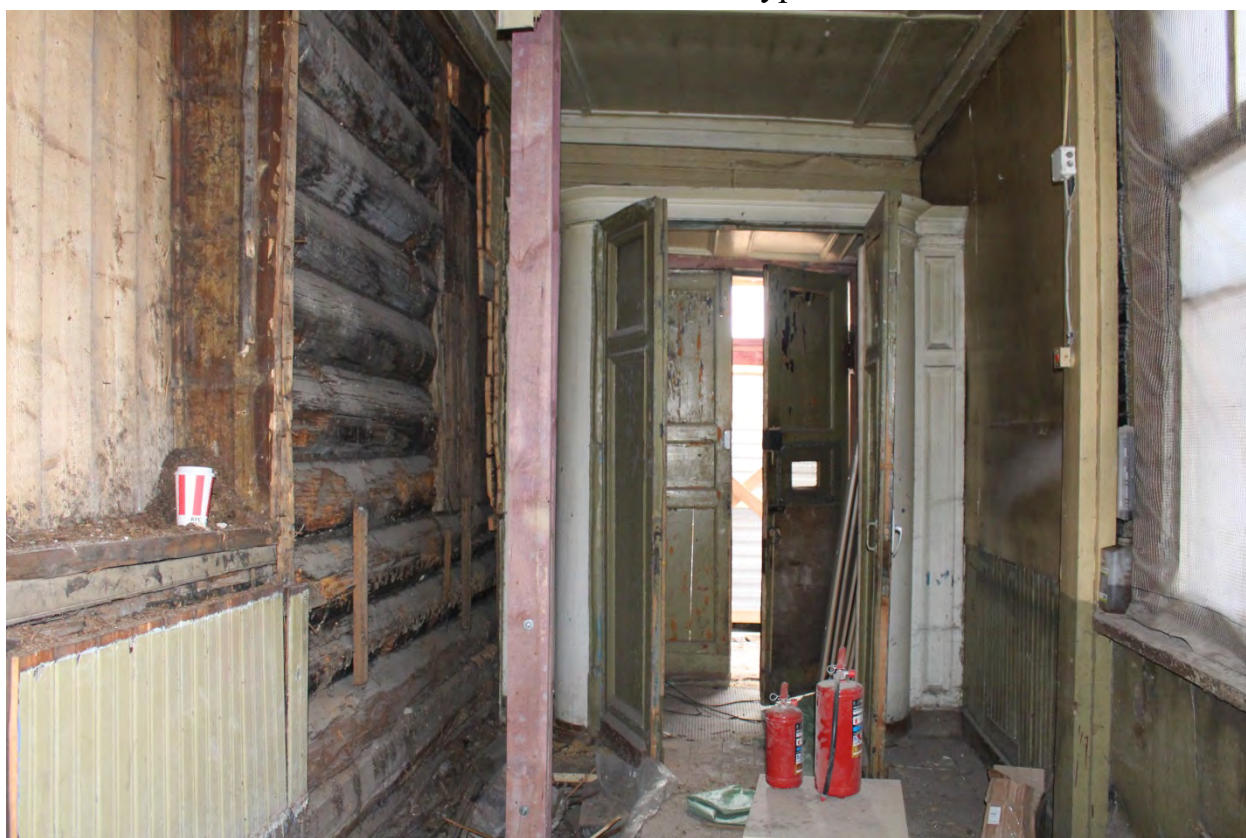
Фото 20. Вид на тамбур.
