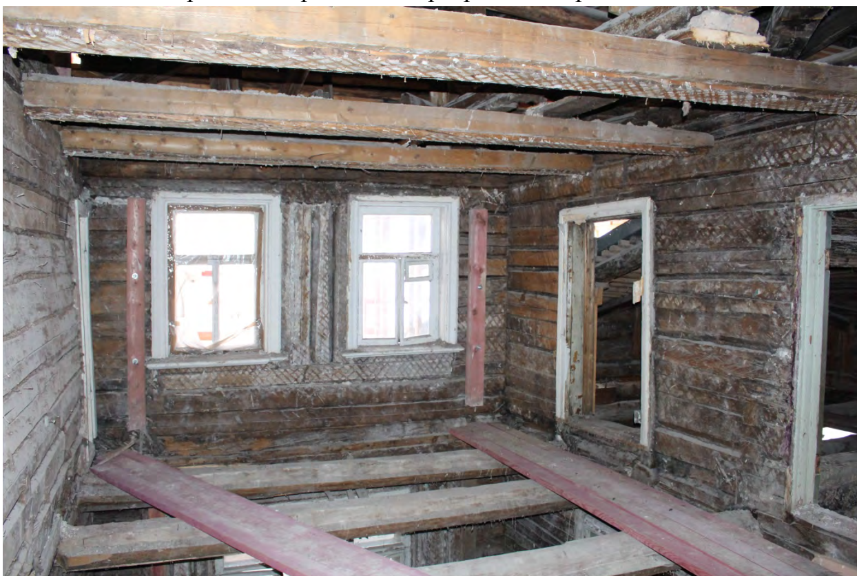
Фото 46. Вид помещения на юго-востоке второго этажа.
