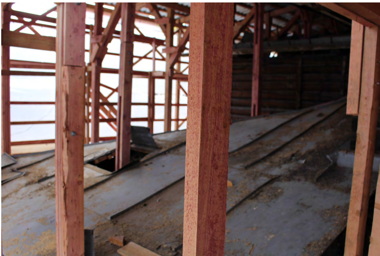
Фото 71. Вид на крышу западной части.
