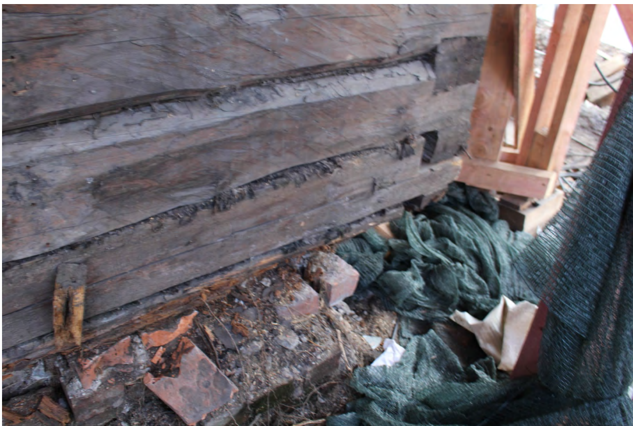
Фото 7. Фрагмент цоколя с севера.
