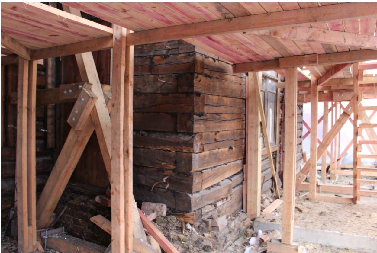
Фото 13. Угол юго-восточного фасада.
