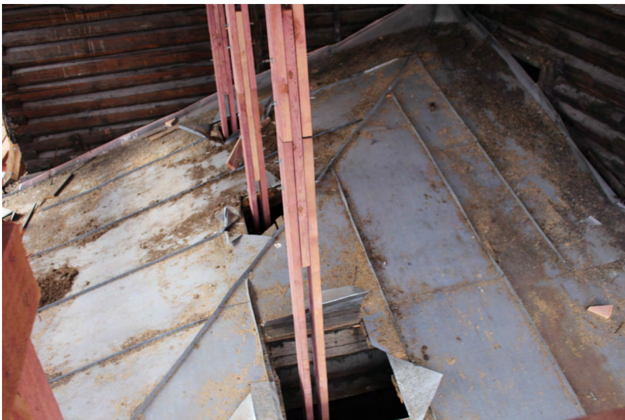
Фото 73. Вид на южную часть кровли.
