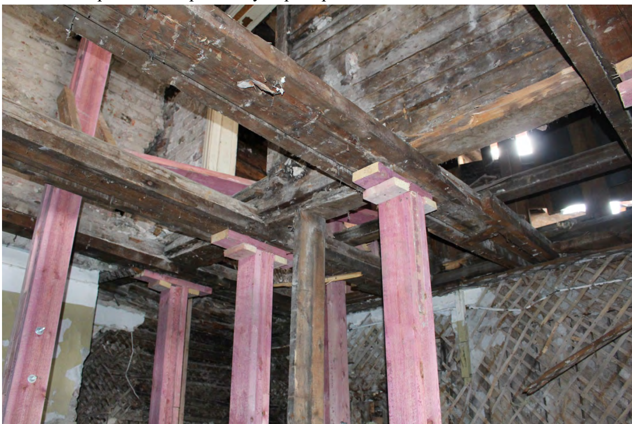
Фото 40. Фрагмент перекрытия в юго-восточной части.
