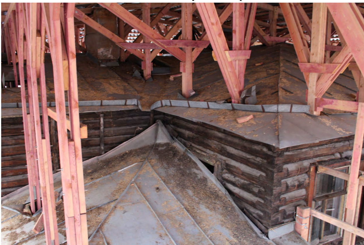
Фото74. Вид на кровлю основного объема с юга.
