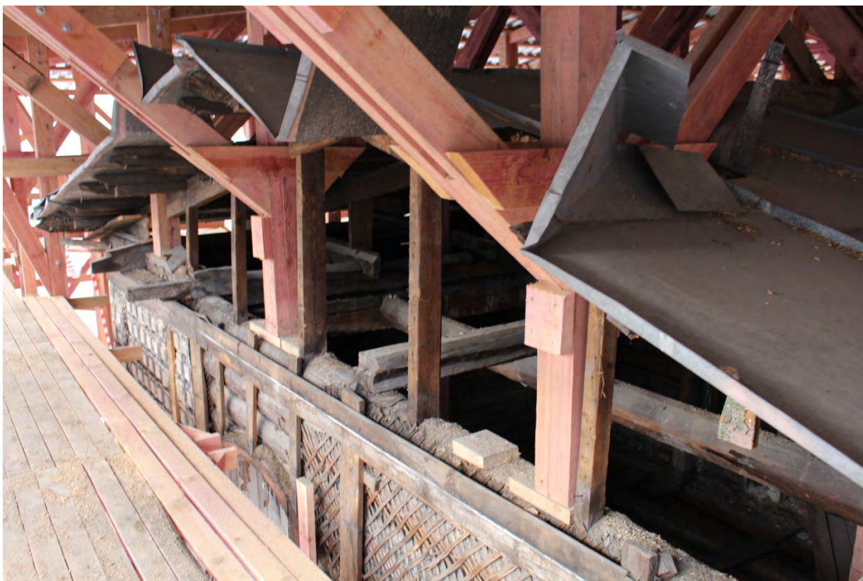
Фото 75. Вид кровли и карниза лицевого фасада.
