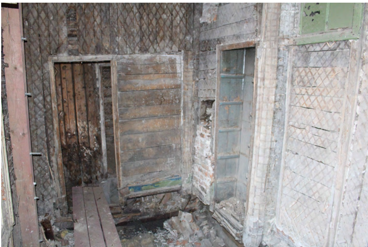
Фото 22. Помещения на северо-западе.
