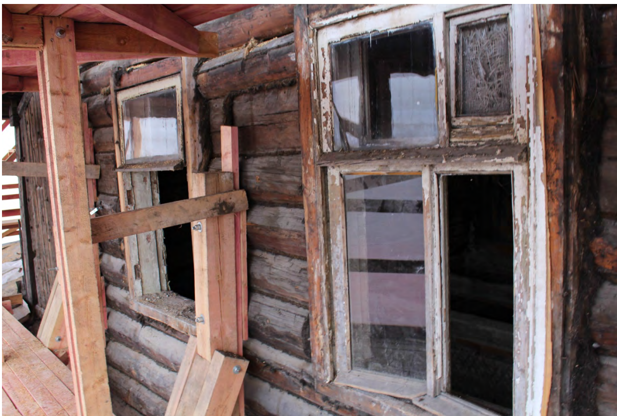
Фото 69. Оконные проемы северного фасада второго этажа.
