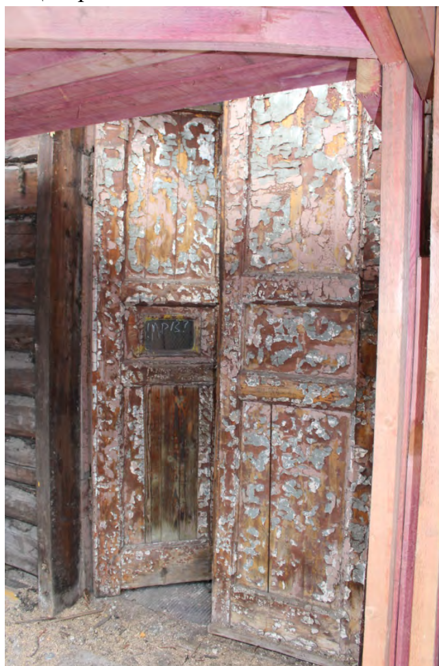
Фото 16. Главный вход со стороны лицевого фасада.
