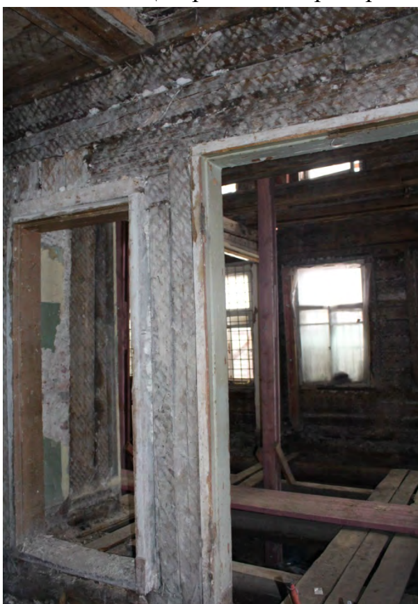
Фото 28. Вид на входы в юго-западные помещения.
