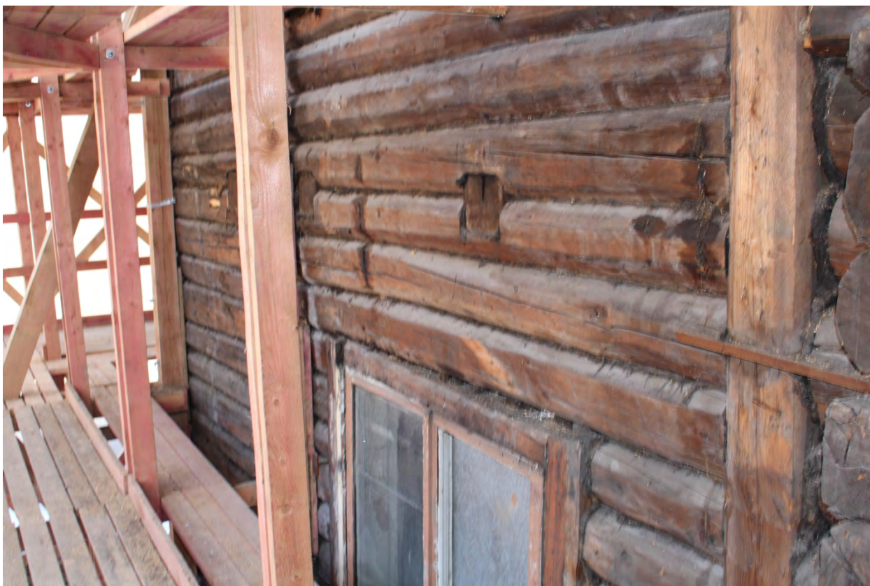
Фото 61. Фрагмент фасада восточного угла второго этажа.
