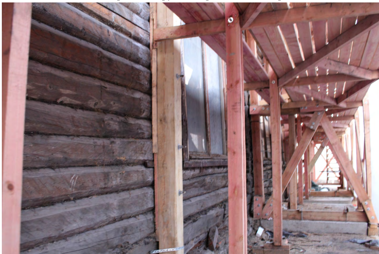
Фото 10. Вид северо-восточного фасада с юго-востока.
