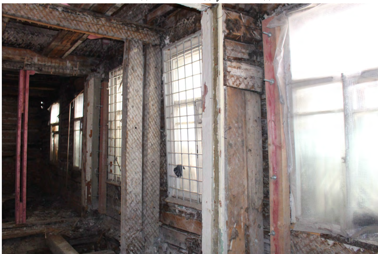
Фото 30. Вид оконных заполнений главного фасада со стороны помещений.
