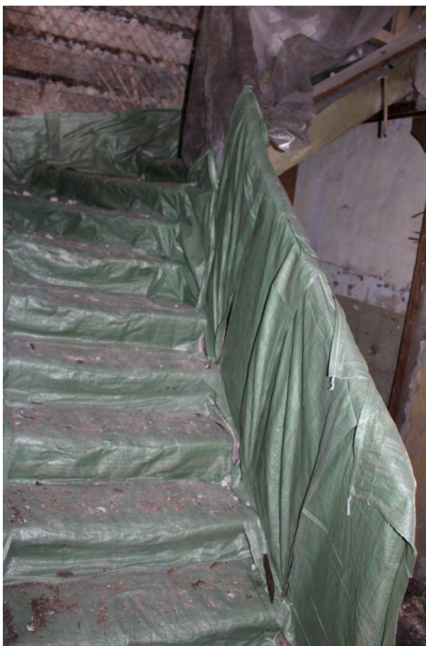
Фото 41. Лестница на второй этаж.
