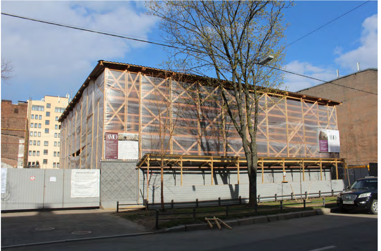
Фото 3. Общий вид с запада.
