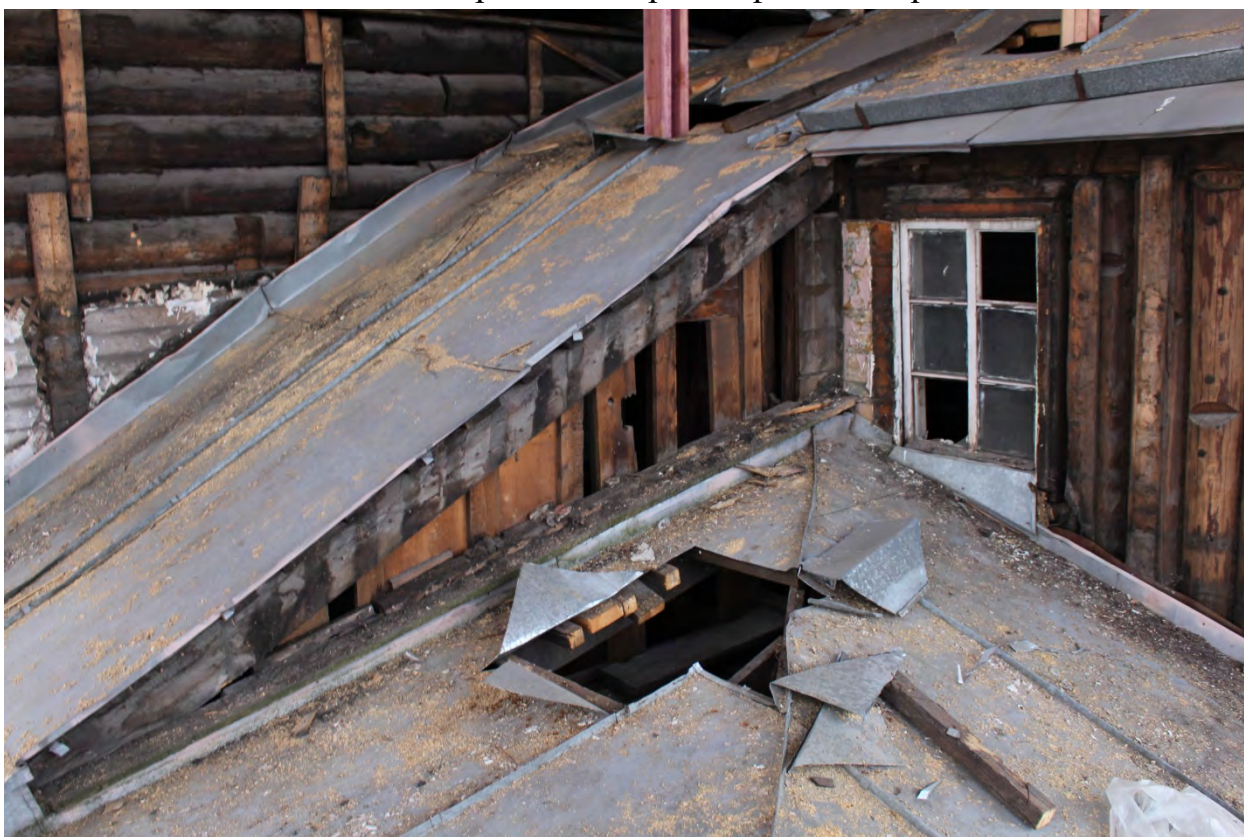
Фото 70. Вид на кровлю с севера.
