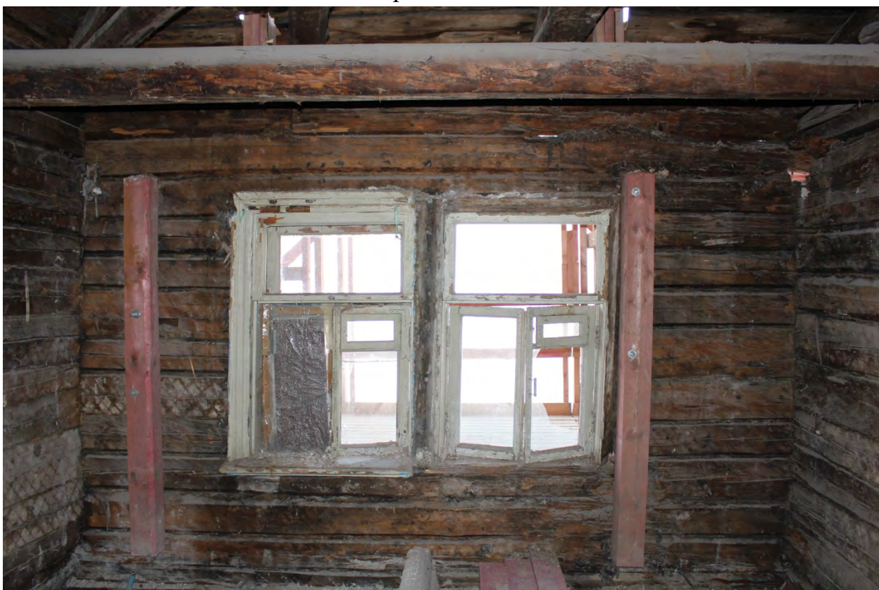
Фото 52. Проемы на северо-востоке второго этажа.
