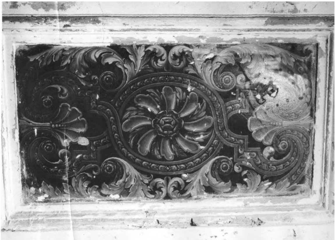
Илл. 52. Расчистка панелей от сплошной закраски. СНПО «Реставратор» Фотография. 1985 г. Архив КГИОП
