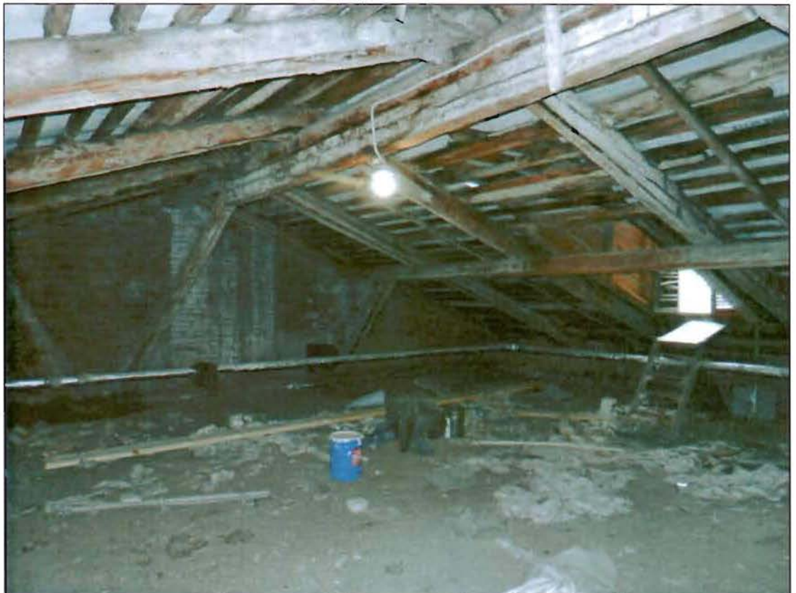
35. Стропильная система. Общий вид.
