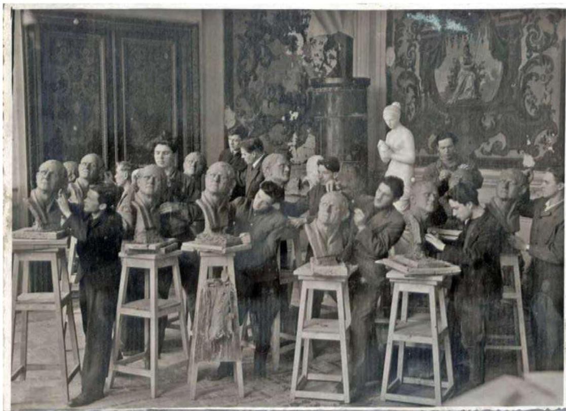
Илл. 47. Ленинградское высшее художественно-промышленное училище (ЛВХПУ). Учебная мастерская в бывшем Зале Людовика XIV. Нач. 1950-х гг. СПГХПА им. А.Л. Штиглица Со стальных панно частично снята бумага, росписи частично повреждены
