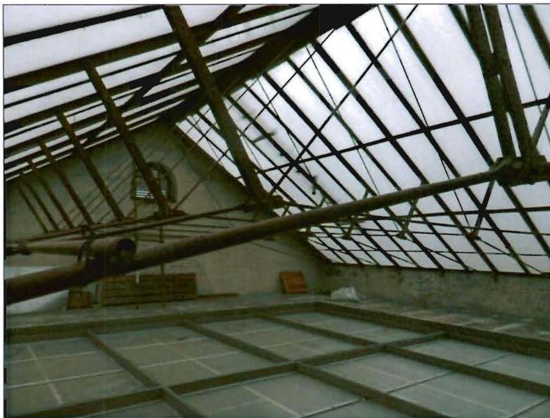
36. Металлические фермы над световым фонарем парадной лестницы.
