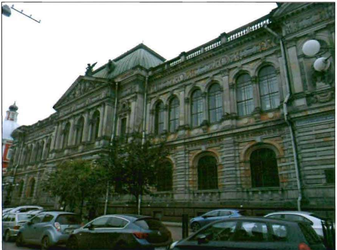
1. Общий вид с северо-востока.
