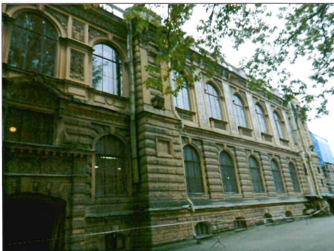
7. Северный дворовый фасад. Общий вид.
