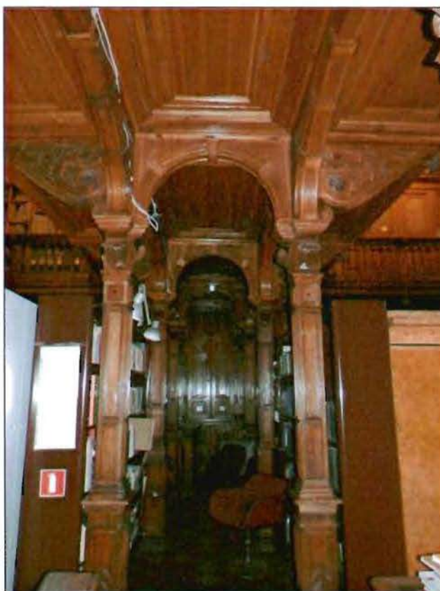
39. Помещение № 1-Н (271). Деревянные колонны.
