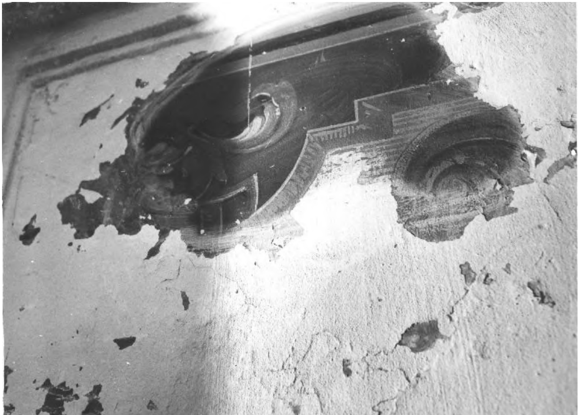
Илл. 51. Расчистка стальных панно от сплошной закраски. СНПО «Реставратор» Фотография. 1985 г. Архив КГИОП
