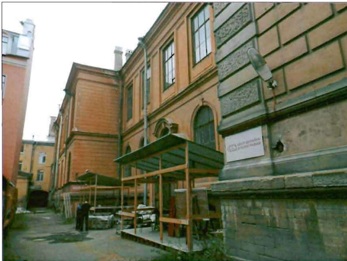
6. Южный дворовый фасад. Общий вид.
