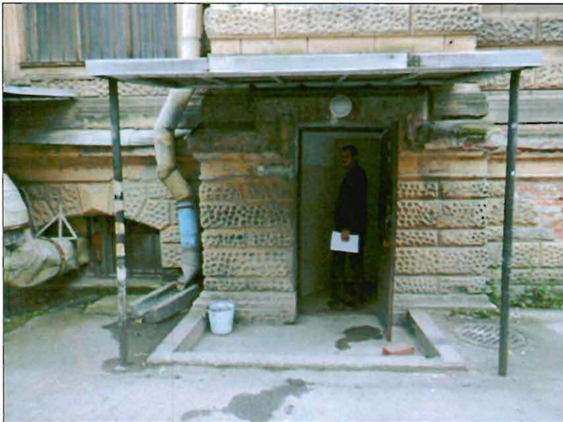
9. Северный дворовый фасад. Фрагмент.
