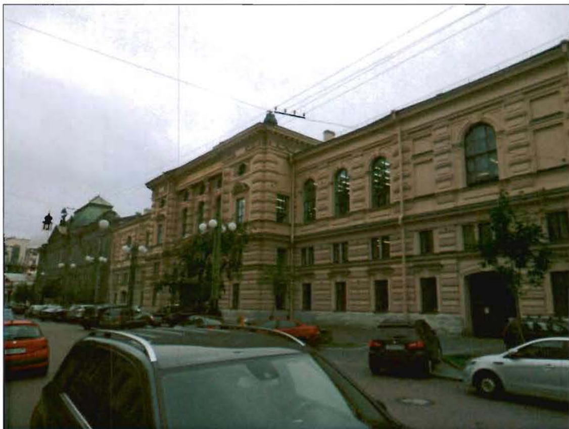
28. Лицевой фасад. Общий вид.
