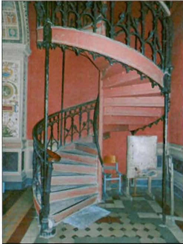
18. Помещение № 1-Н (285). Лестница.
