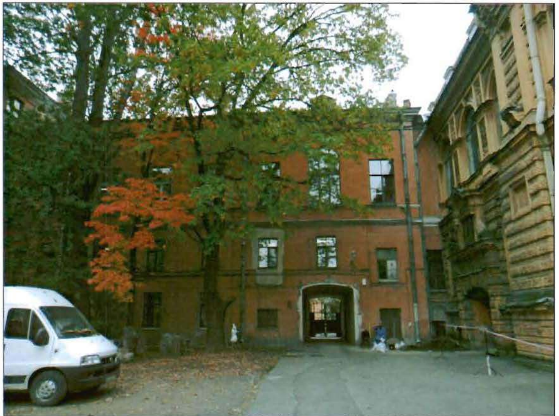
31. Восточный дворовый фасад. Общий вид.
