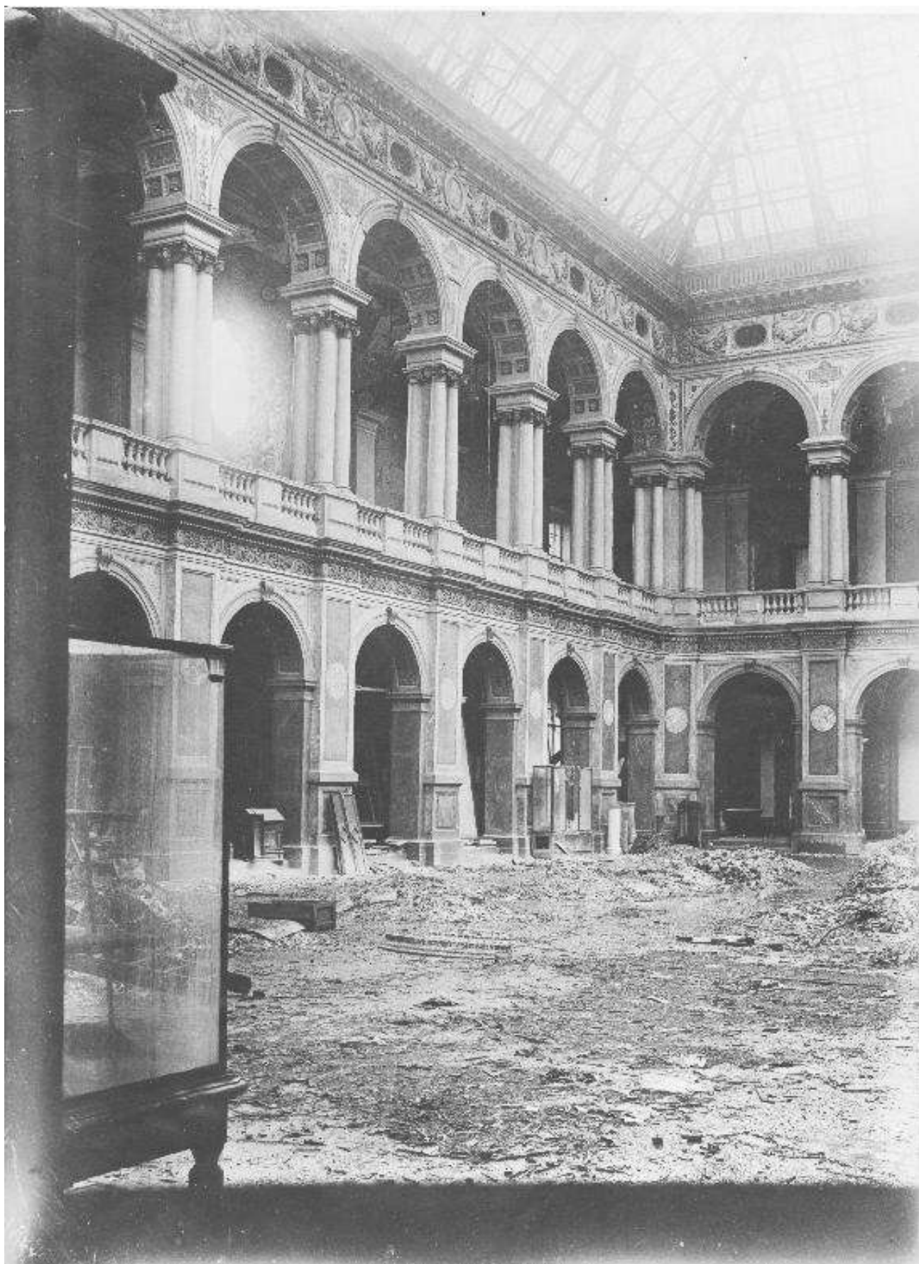
Илл. 43. Большой Выставочный зал Музея. Состояние помещения после попадания снаряда Октябрь 1941 г. Фотография Государственного Эрмитажа. Архив КГИОП
