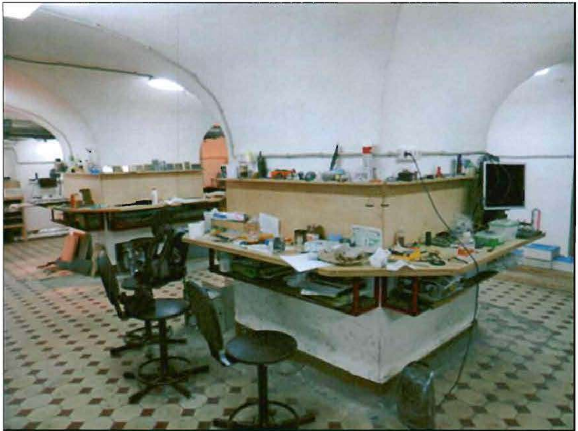
20. Помещение в цокольном этаже.
