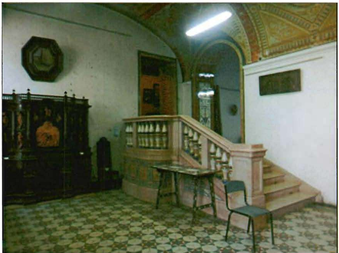
17. Помещение № 1-Н (334). Лестница.
